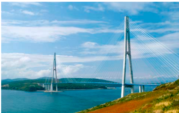
Рисунок 2 – Мостовой переход на остров Русский через пролив Босфор Восточный, г. Владивосток
