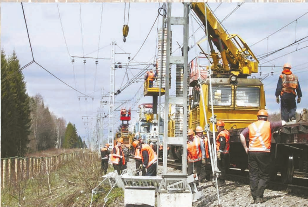
Монтаж опытных участков контактной сети для скорости движения 250 км/ч на участке Калашниково - Лихославль Октябрьской железной дороги
