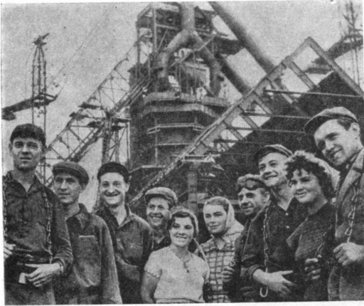
Комсомольці — будівники доменної печі на заводі «Азовсталь». 1957.
