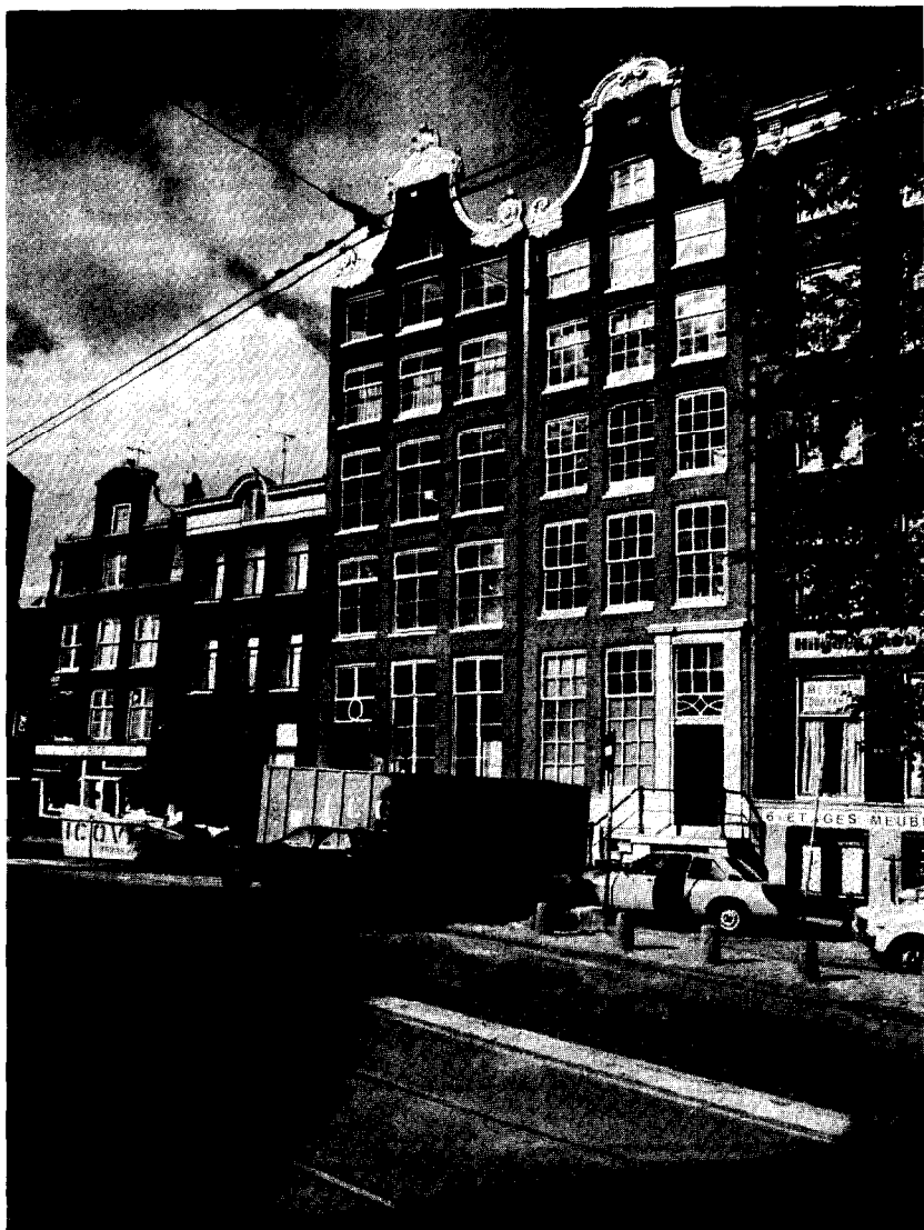
Nieuwezijds Voorburgwal 298 en 296 na de restauratie Foto Y. Bouberg Wilson 21.9.1979.
