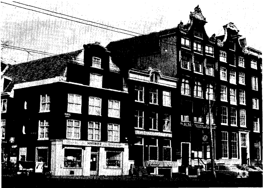
Nieuwezijds Voorburgwal 298 en 296 vóór en na de restauratie Foto C. P. Schaap 21-4-1962.
