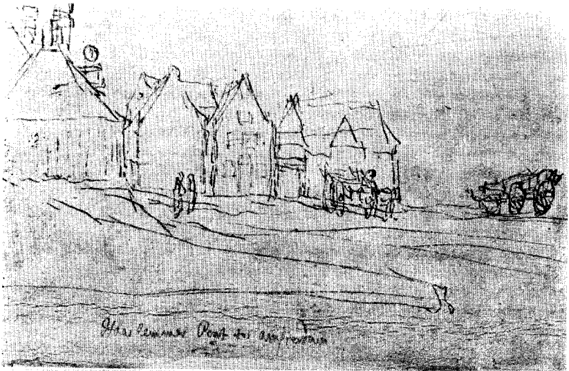
Detail achterzijde met de Haarlemmerpoort gezien vanaf het Wagenplein.
