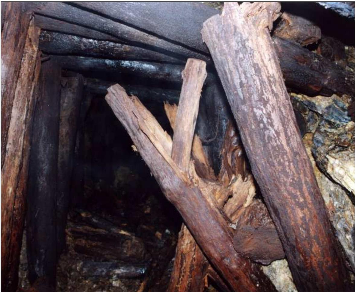
Bild 2: Holzbaus in einer Strecke des Altwismutbergbaus (Alter ca. 50 Jahre)
