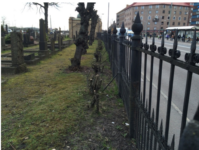
Figur 36. Insiida staket utmed Gamla begravningsplatsen.
