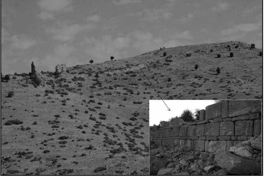
Resim 10: Güney sur duvarları
