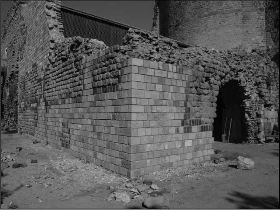
Resim 2: Bodrumu çevreleyen duvarın onarım sonrasındaki görünümü.
