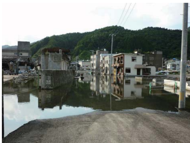
地盤沈下で満潮になると港の外まで今でも浸水します
