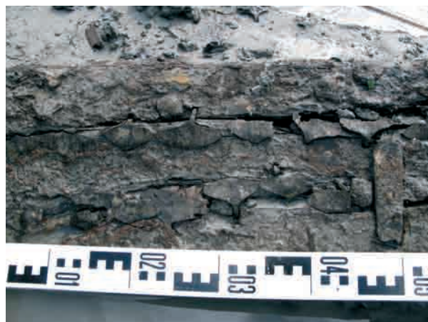
Il. 93. Reperacja pęknięcia przy szwie poprzecznym na poszyciu lewej burty pomiędzy wręgiem XII i XIII
