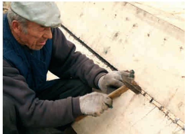
Il. 28. Uszczelnianie metodą klamrową kadłuba promu z Basoni w 2008 roku (fot. R. Łapiński)
