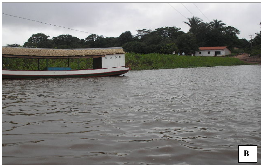
Figura 5 – A. visualiza-se a estrutura sem concreto (tipo enrocamento) da Barragem do Lago Cajari em novembro de 2005. B. observa-se a estrutura atual da barragem, com algodão do campo plantado em suas margens para evitar erosão.
