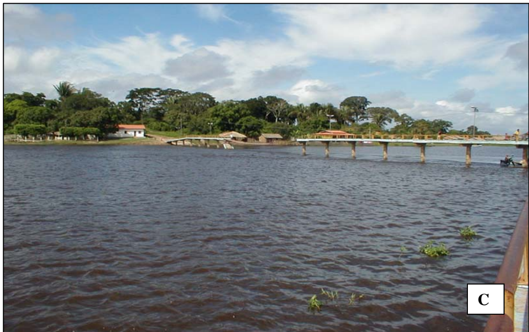
Figura 4 – A. Mostra o trilho de passagens das embarcações. B. Evidencia parte da estrutura da primeira barragem (1997), onde se pode observar que a mesma possuía concreto na crista e laterais, passarela para pedestres e trilhos para passagem de embarcações. C. mostra o início do rompimento desta barragem.
