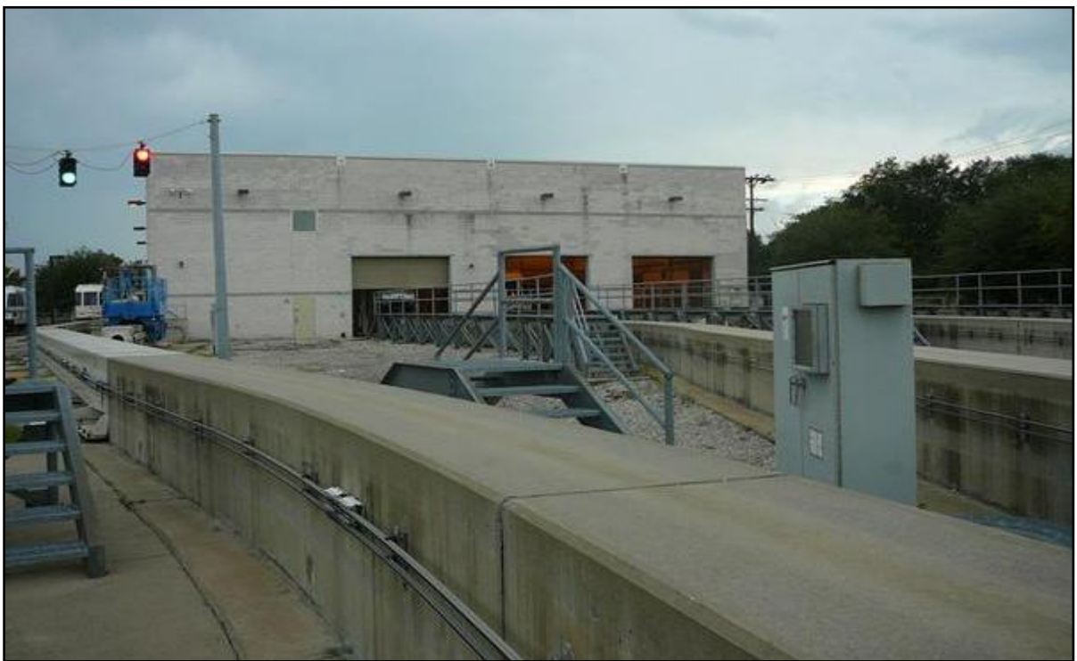
รูปที่ 3.9.3 - 9 ลักษณะอาคารโรงซ่อมบำรุงทางรถไฟฟ้า
