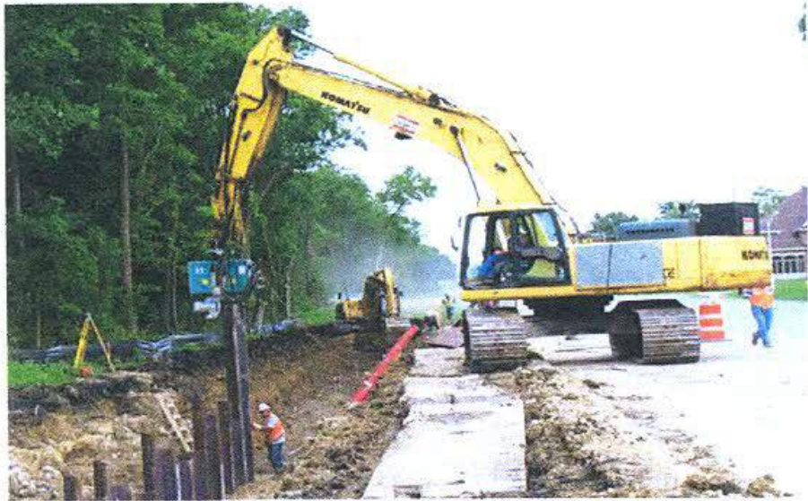
ภาพที่ 7.1.3 - 1 ภาพตัวอย่างการตอกแผ่นเหล็กพืด (Steel Sheet Pile)
