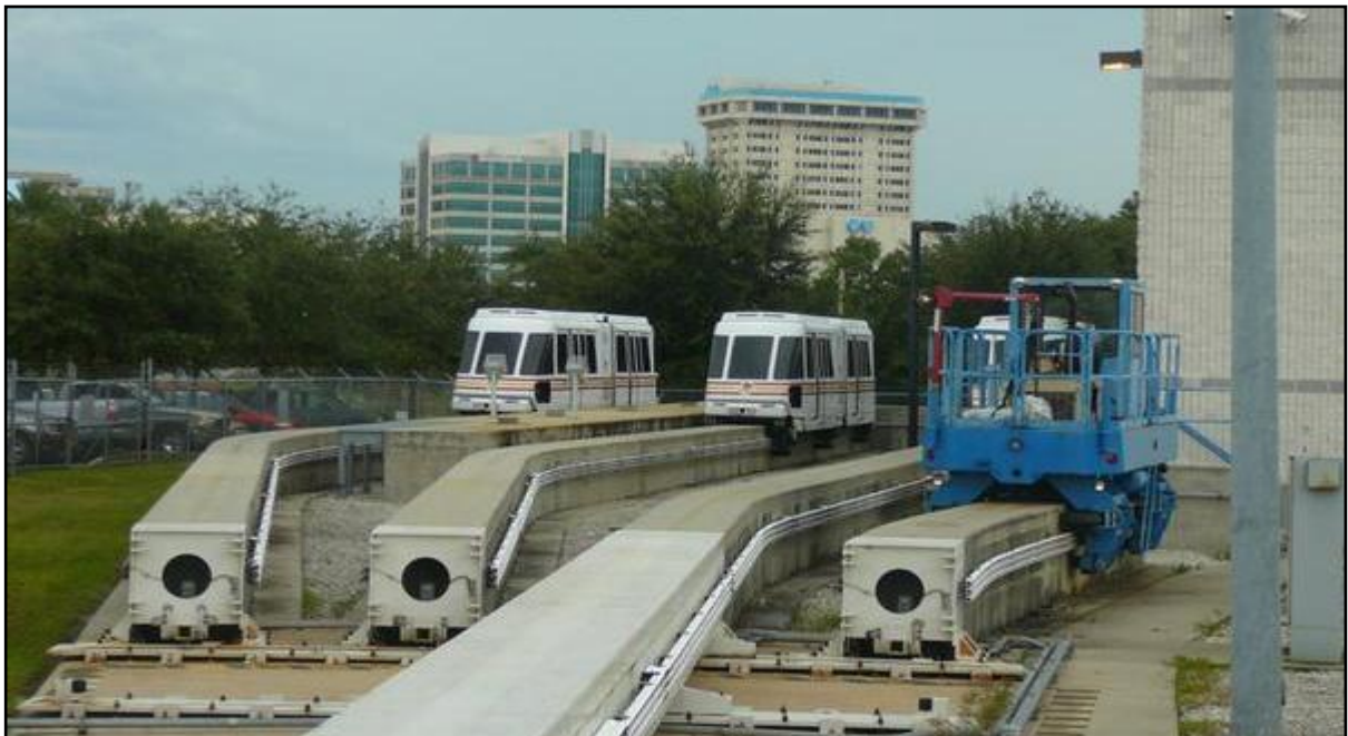
รูปที่ 3.9.3 - 13 ลานจอดรถไฟฟ้า
