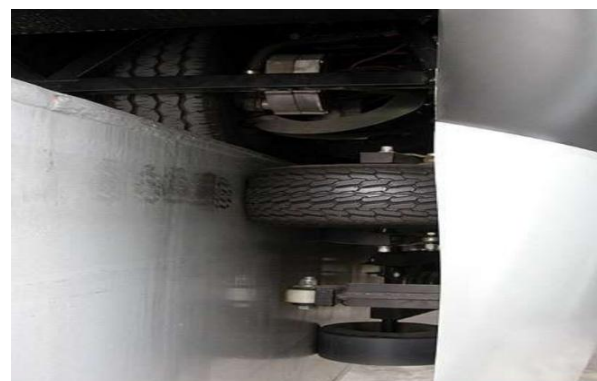
(4) ระบบล้อยางด้านข้างทั้งสองด้าน (Guide wheels) มองจากด้านข้างของทางวิ่งรถไฟฟ้า Monorail
