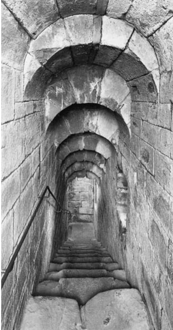
Abb. 25: Kapellenturm, südlicher Treppenaufgang ins erste Obergeschoss. Aus: Meyer 1997: S. 29. Foto: Sigmar Fitting.
