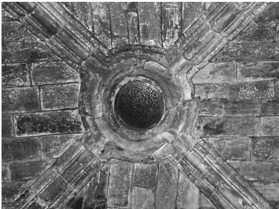
Abb. 14: Deckenöffnung in der Kapelle. Foto: R. Zimmermann.
