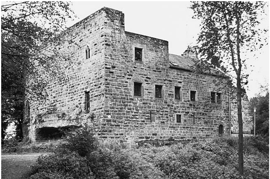
Abb. 9 Wilenstein: Wilenstein. Schildmauer und Falkensteiner Bau von Norden (Foto: Uwe Welz).
