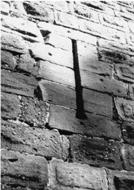
Abb. 10: Birkenfels am Odilienberg, Schar- te im Erdgeschoss des Wohnbau- es, vor 1262 (Th. Biller 1985).
