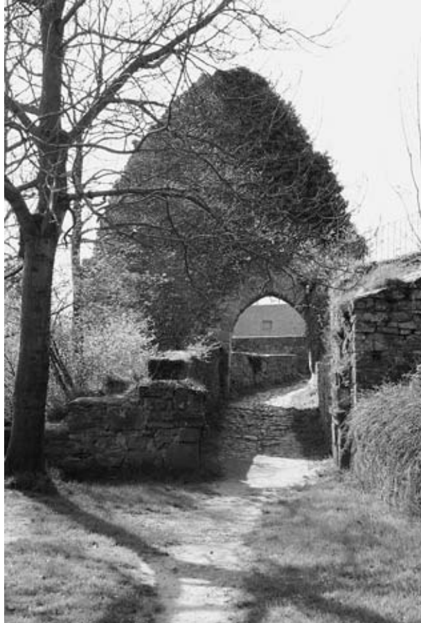
Abb. 7: Lichtenberg, untere Burg, ehem. Torhaus mit verschwundener Kapelle, Ansicht von Osten, 2007 (Aufnahme: Ulrich Burkhart).
