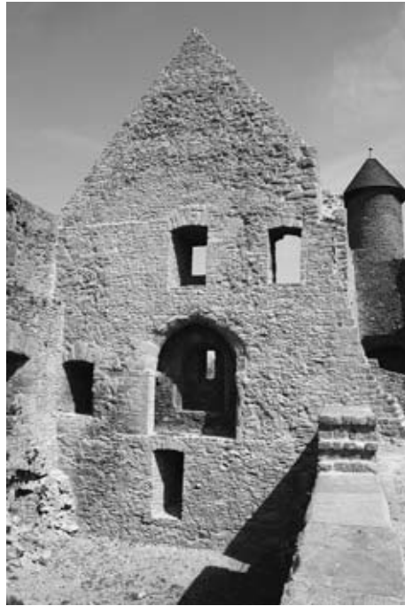
Abb. 8: Lichtenberg, obere Burg, sog. Ostpalas mit Altarnische in der Ostwand, Blick von Westen in das Innere, 2007 (Aufnahme: Ulrich Burkhart).
