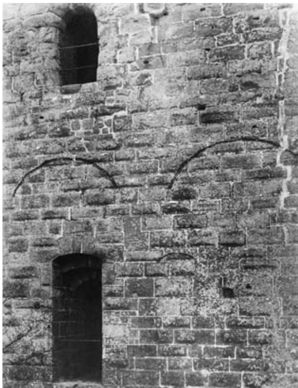
Abb. 21: Kapellenturm, Nordseite, zweites und drittes Geschoss, vor 1938. Aus: Meyer 1997: S. 76.
