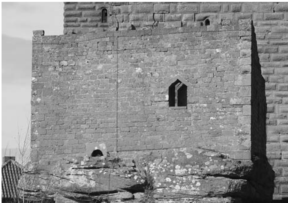
Abb. 7: Wachthaus von Süden, 2007. Foto: R. Zimmermann.
