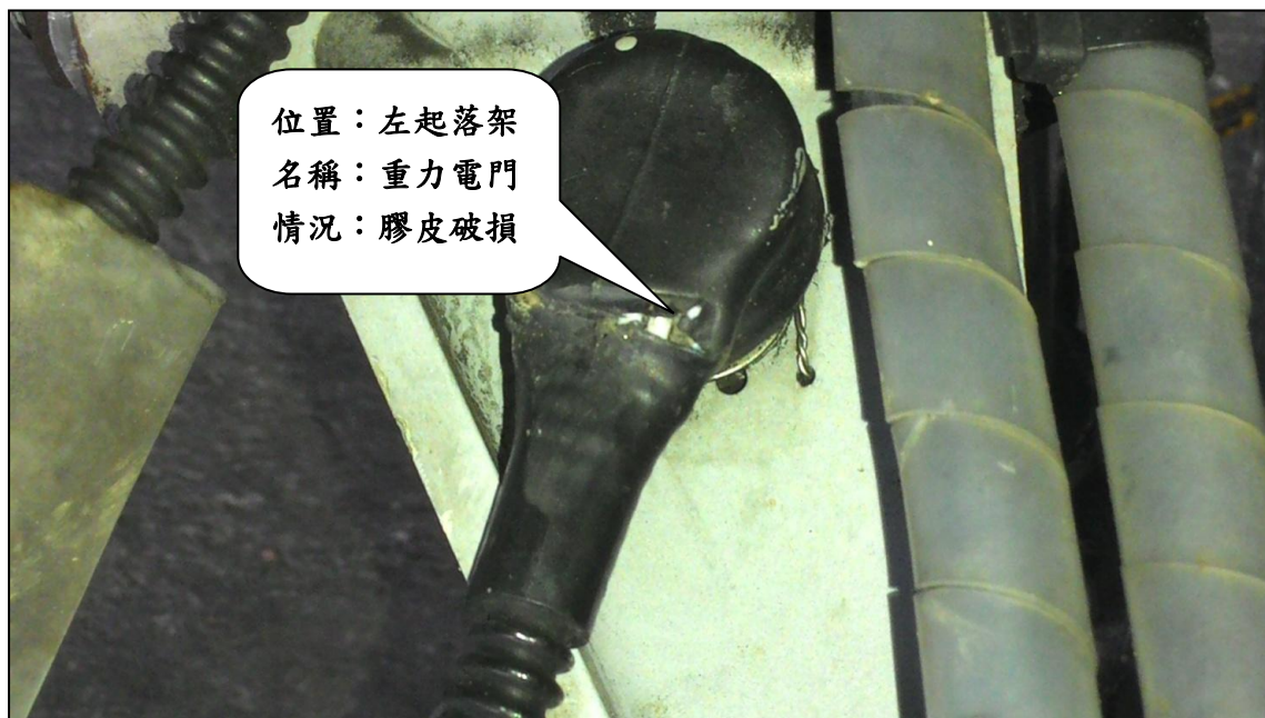
圖 1.6-2 左起落架重力電門膠皮破損
