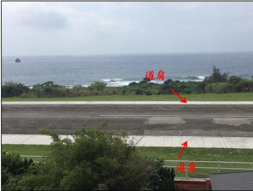
圖 1.10-2 蘭嶼機場跑道水泥混凝土道肩
