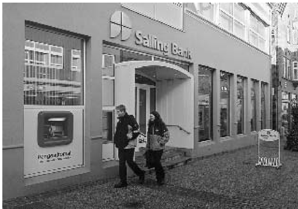
Salling Bank efter ombygningen i 1990-1992.
