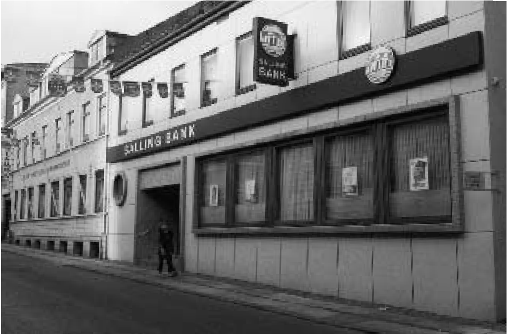
Salling Bank efter ombygningen i 1972-1973.
