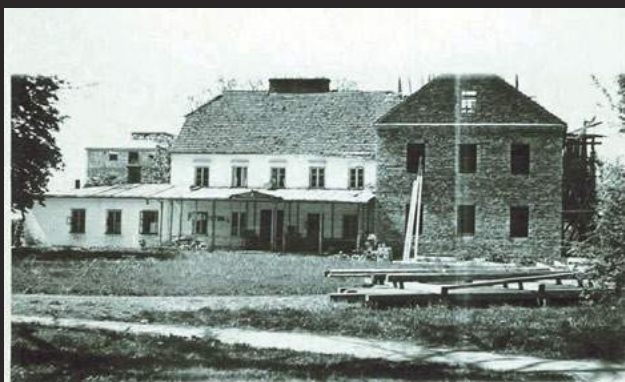
Przebudowa domu zakładowego 1948-1949
