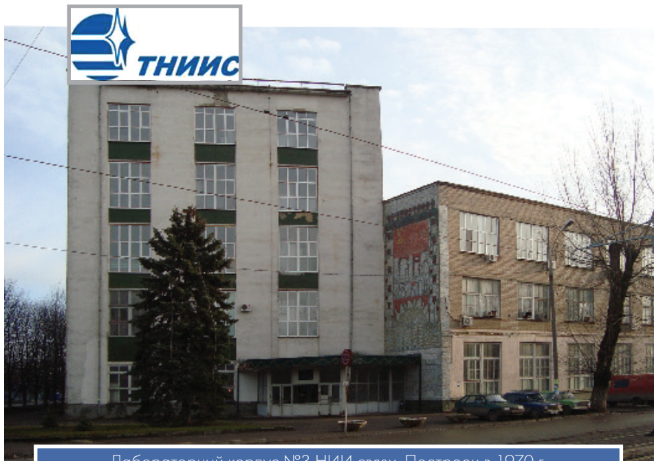
Лабораторный корпус №3 НИИ связи. Построен в 1970 г.
