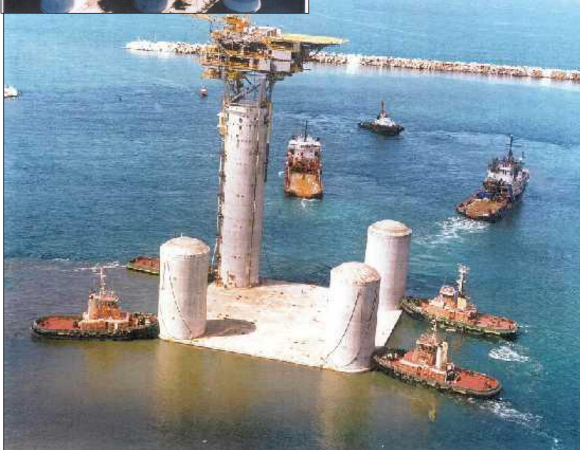
Beam C en remorquage
