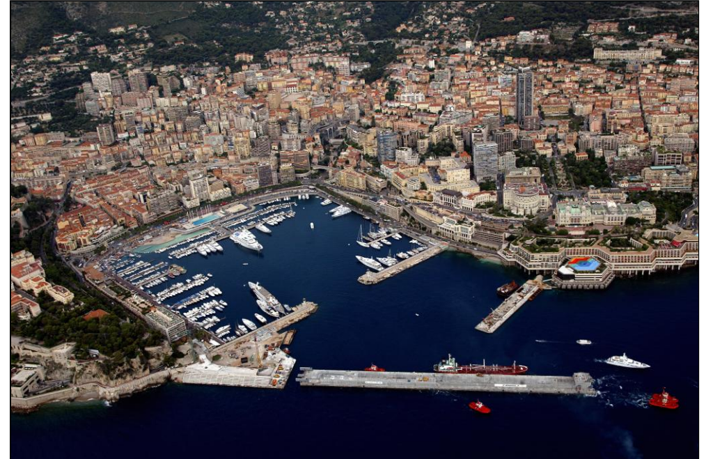
Remorquage et mise en place du quai flottant
