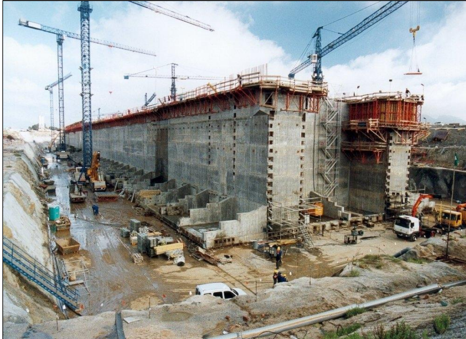
Construction du quai
