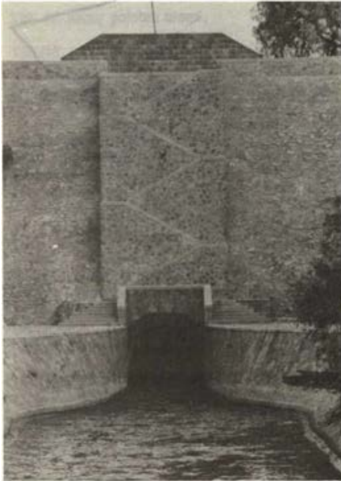
Desemboque del nuevo Túnel de Tequixquiac
