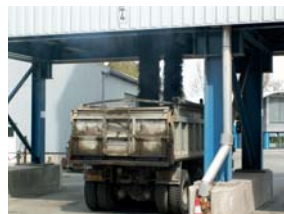
Silo de stockage à chaud
