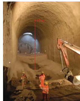
Kaverne mit Söhlengewölbe. Im Hintergrund sieht man den Anschlag des Notstollens sowie den fertiggestellten Kavernebauhof.
