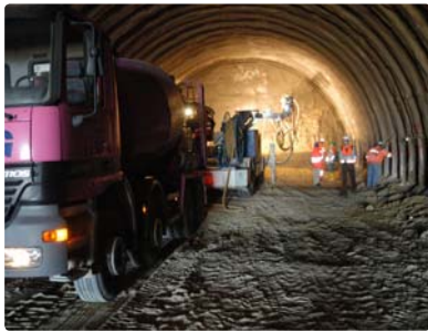
Sprengstein: Betonmischfahrzeug und Sprengbohrer
