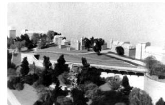
Ausgang Tunnel Eichenberg (offene Bauweise)
