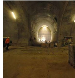
Innengewölbe der Kaverne
