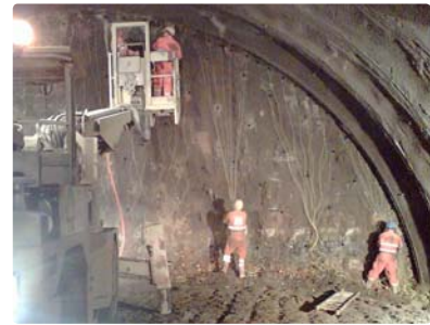
Beschleichen der Sprenglöcher
