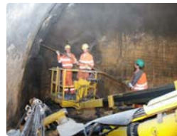
Manuelle Einbau der Anker
