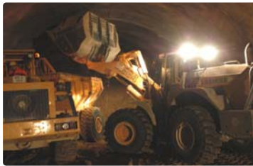
Schutteln: Beladen des Dumpers durch Radlader
