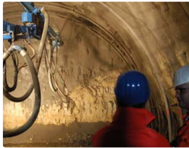
Sprengstein: Feingesteuerte Spritzbetondecke beim Einrücken eines Gitterträgers
