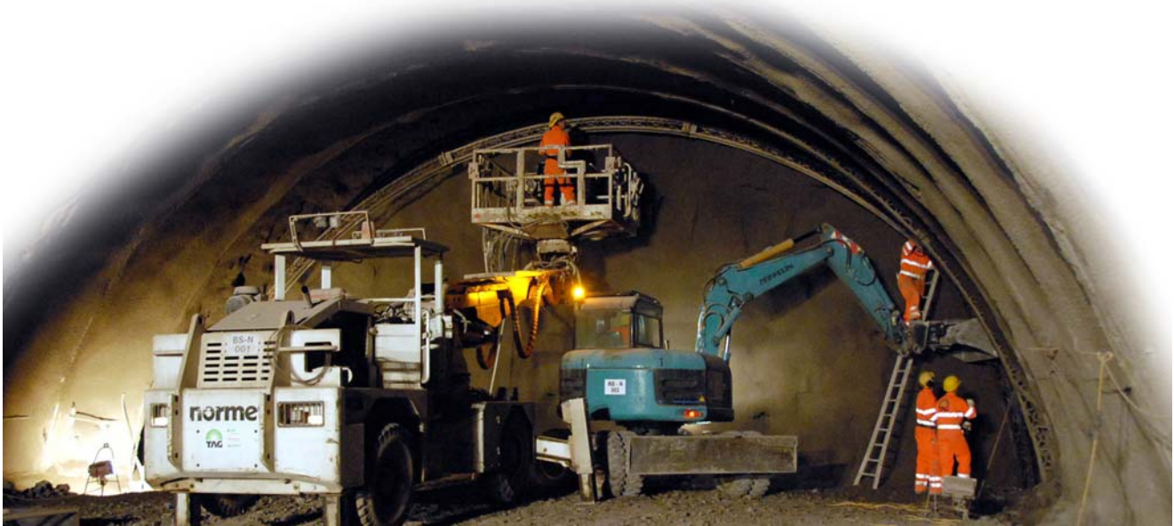
Manuelle Einbau der Anker
