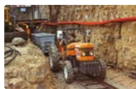
Abtransport des Formbetons
