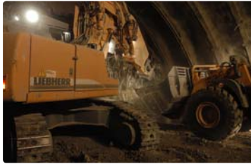
Tunnelbagger im Einsatz
