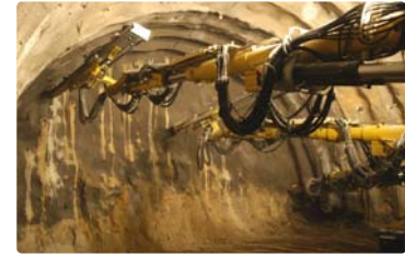
Bohren der Sprenglöcher mit 3-armigen Bohrhülbo
