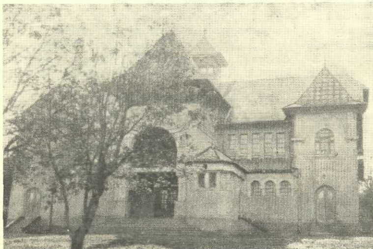
Casa națională din Rășinari a despărțământului Sibiu al Astrei (1930)
