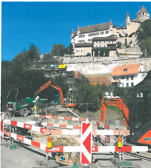
Rete di teleriscaldamento di Lucens in costruzione, Origine: Energia-legno Svizzera
