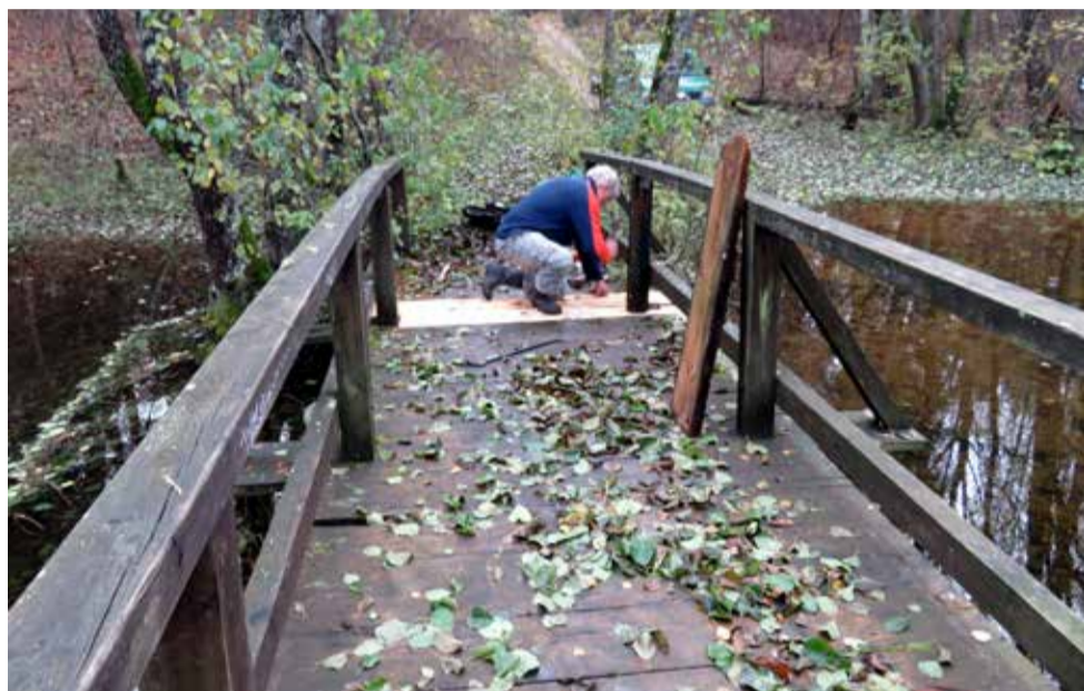
Tilto per Grauzės upelį remonto darbai
