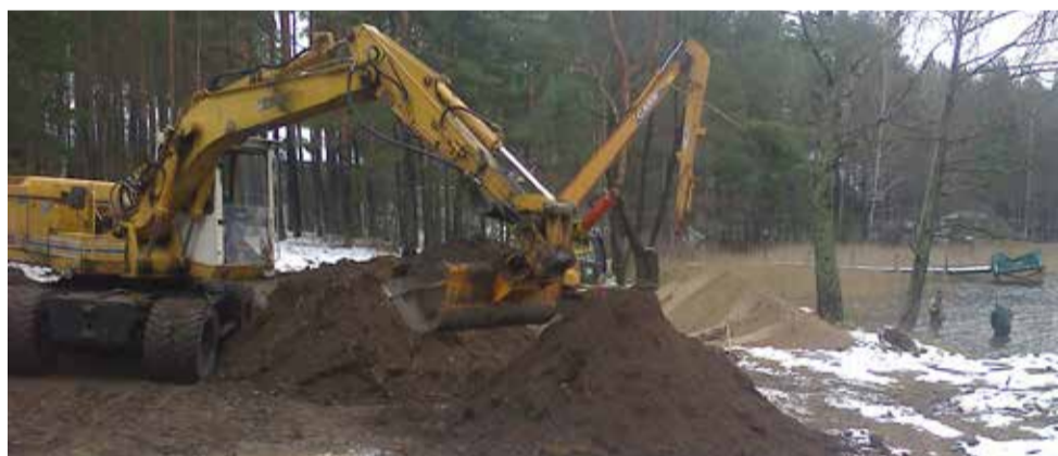
Įrenginėjama valčių nuleidimo vieta
