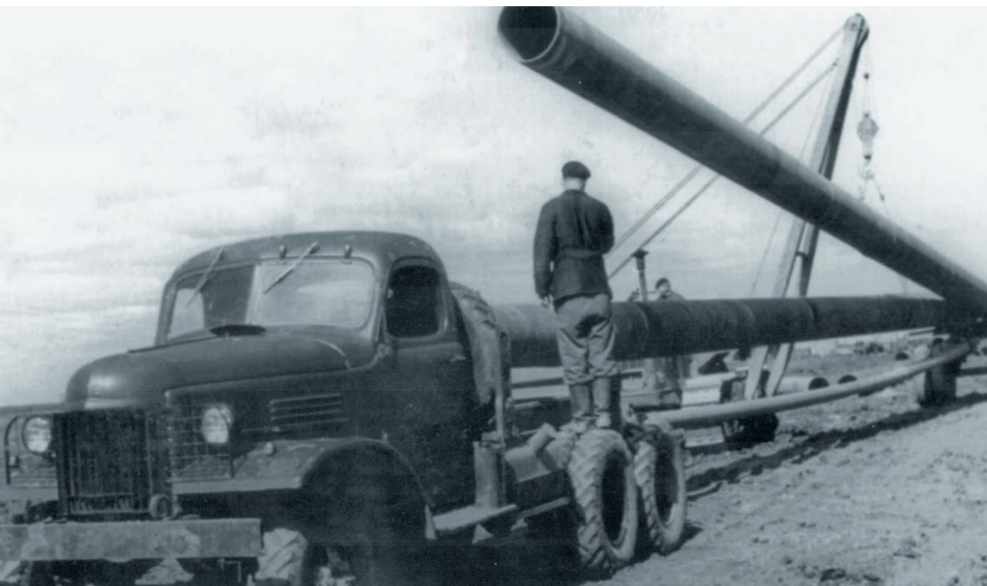
Строительство трубопровода на месторождении, начало 1980-х
