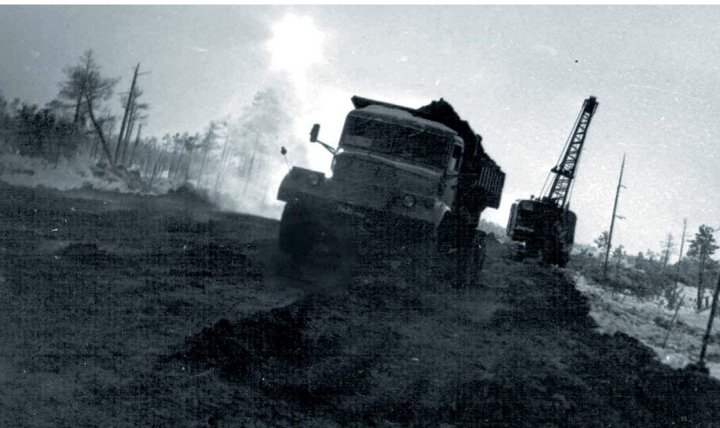
Отсыпка промысловых дорог, 1980-е годы
