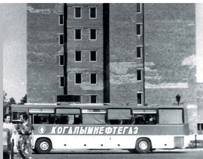
1989 год. Заканчивается строительство девятиэтажного административного здания ПО «Когалымнефтегаз».
