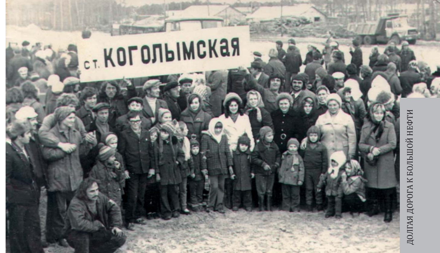
Митинг, посвященный укладке последнего звена на 91-м километре, 20 сентября 1977 года
