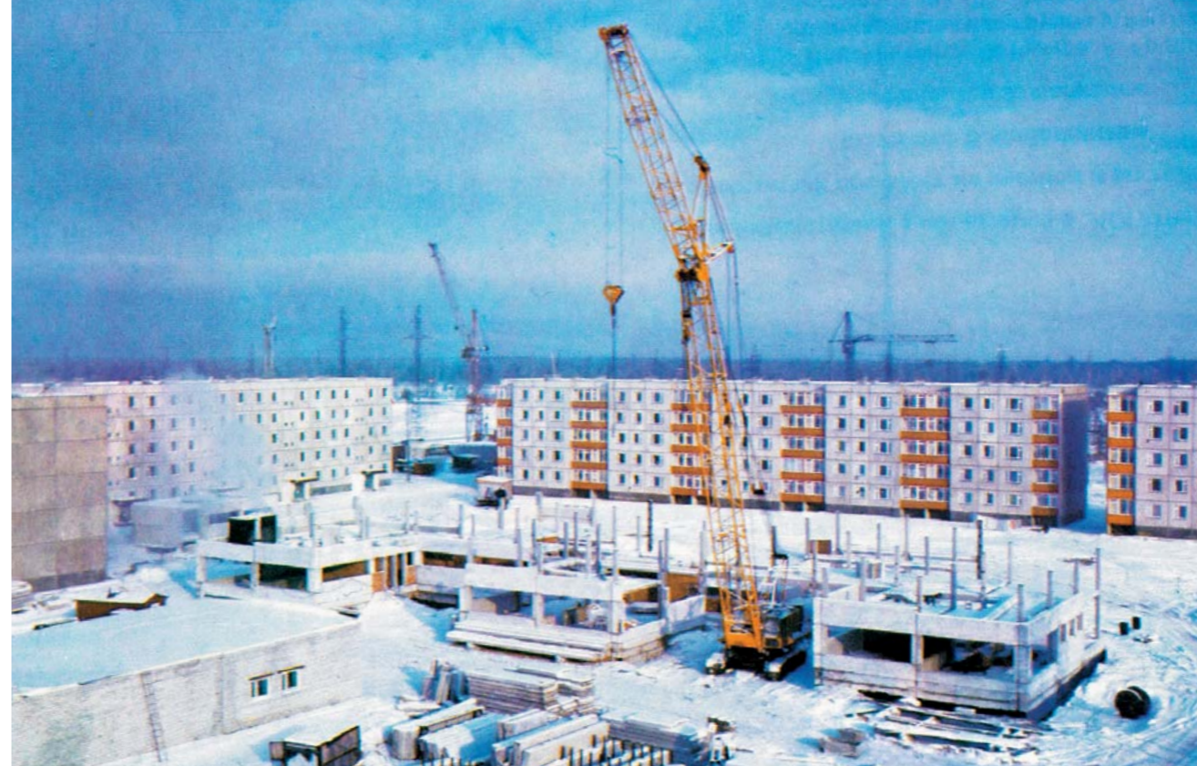
Строительство детского сада
