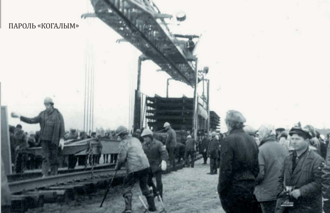
Уложен первый километр рельсов в сторону будущей станции Коголымской, 21 апреля 1976 года
