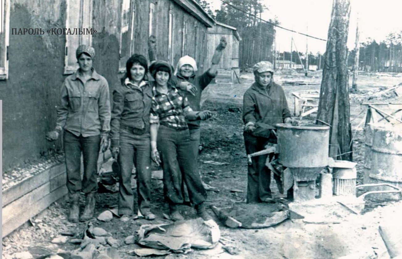
На строительстве общежития, конец 1970-х годов
