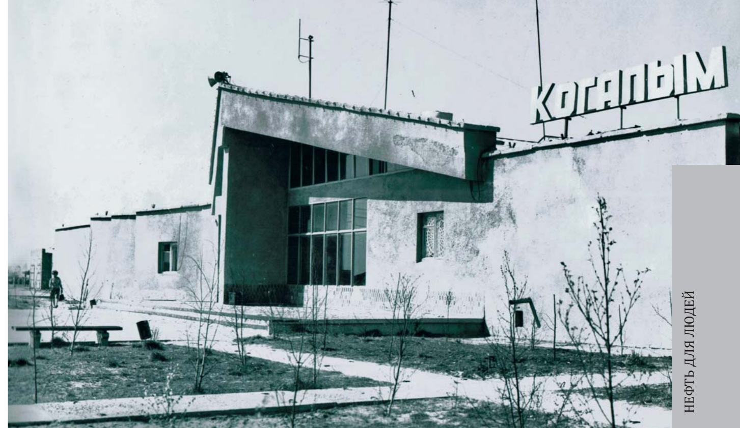
Здание железнодорожного вокзала
