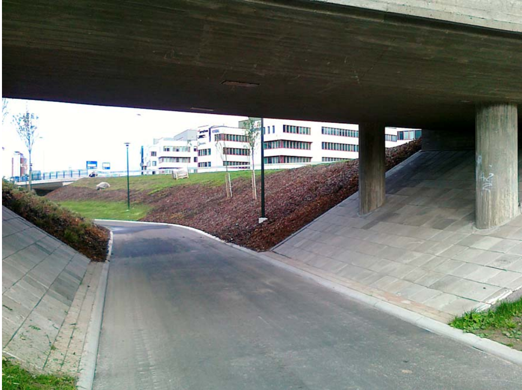
Kuva. Betonilaatoilla verhoillut etuluiskat alikulkukäytävässä. Espoo.
