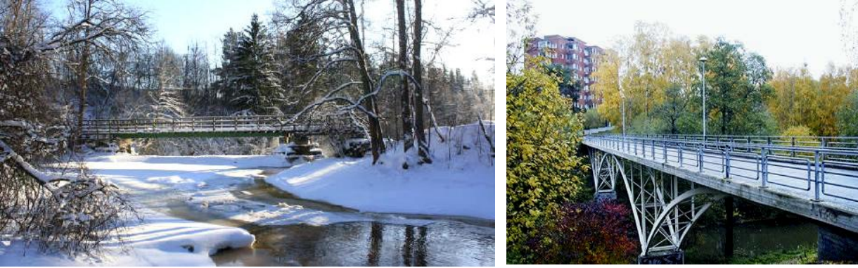
Kevyen liikenteen palkki- ja kaarisilta teräksestä vesistön yli. Oikealla Tourujoen silta Jyväskylässä.
