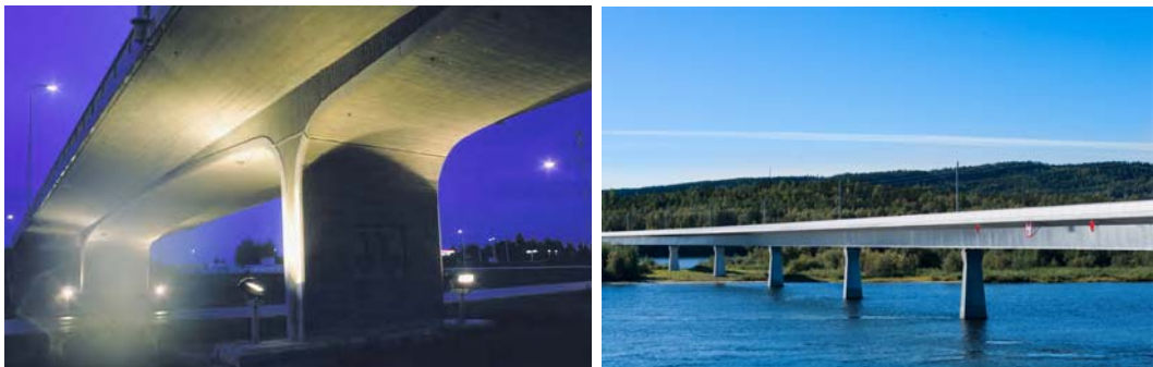
Sillan kokonaisuuteen ja ympäristöön hyvin suunniteltuja pilareita. Vasemman puolinen silta muodostaa portin taajamaan. Oikean puolinen massiivinen rautatiesilta ylittää suuren joen Ruotsissa.
