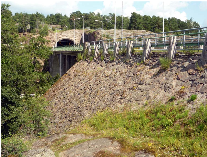
Kuva. Maisemaan sulautunut lohkokiviverhous. Verhous liittyy luontevasti kalliomaastoon. Naantali.
