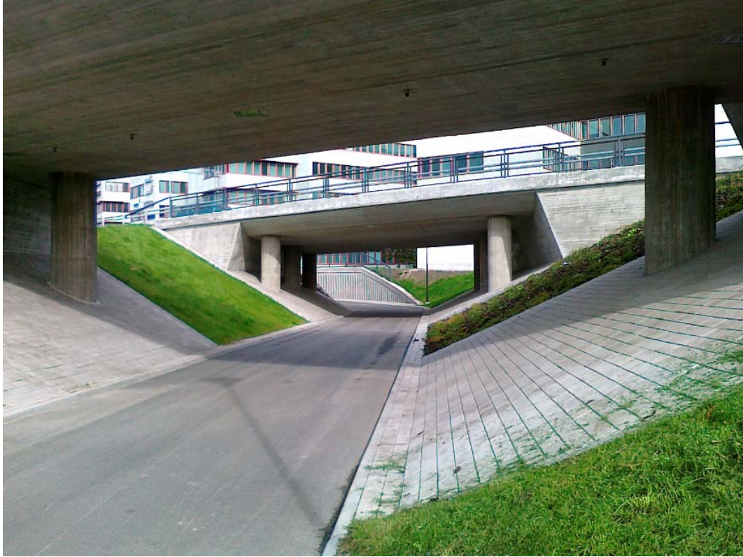
Kuva. Etuluiskissa on käytetty betonikiveä, nurmetukset ja pensasistutukset pehmentävät vaikutelmaa. Siistiä viimeistelyä rakennetussa ympäristössä. Espoo.
