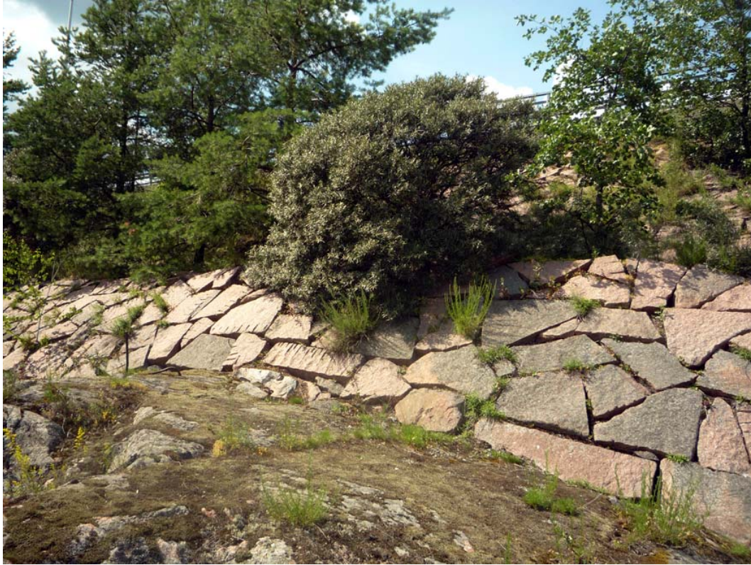
Kuva. Lohkovivellä verhoiltua siltapenkereen terassointia on pehmennetty tyrni-, tervaleppä- ja mäntyistutuksilla. Naantali.
