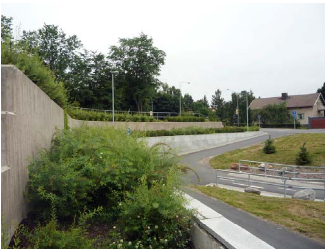
Kuva. Alikulku on sovitettu kaupunkiympäristöön tukimuureja hyväksi käyttäen. Rauma.
