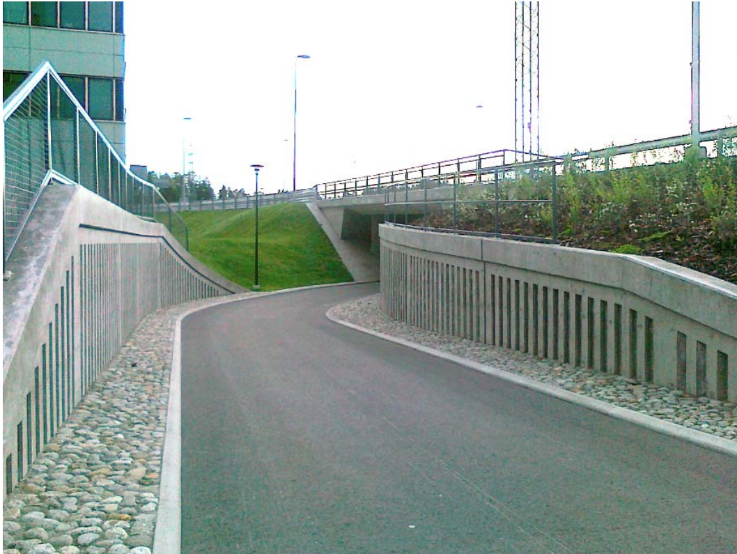
Kuva. Siltaympäristöön liittyvien yksityiskohtien viimeistelyä. Espoo.
