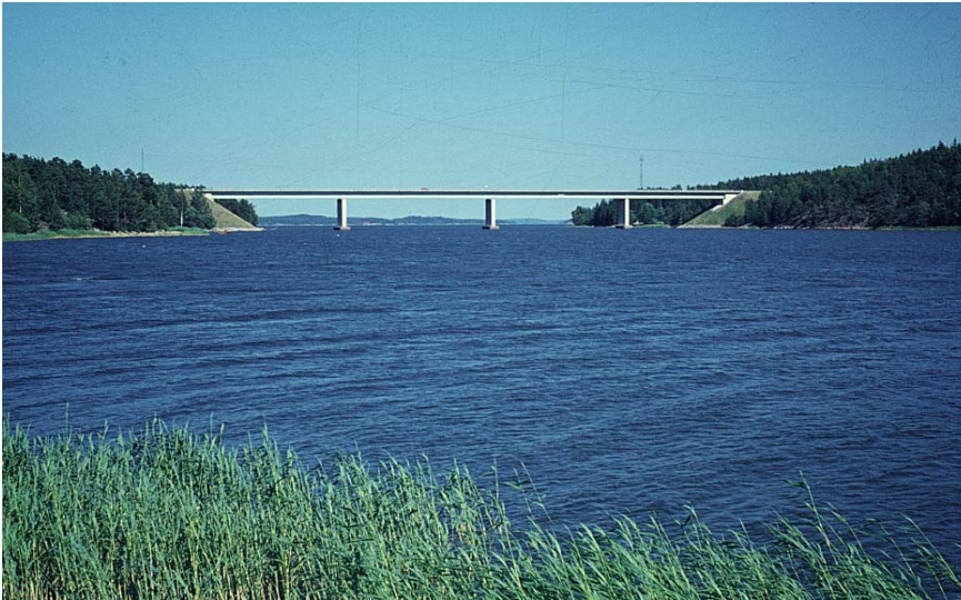
Rungonsalmen silta, Sauvo; teräksinen palkkisilta, aukot n. 80 m ja korkeus 16 m.
