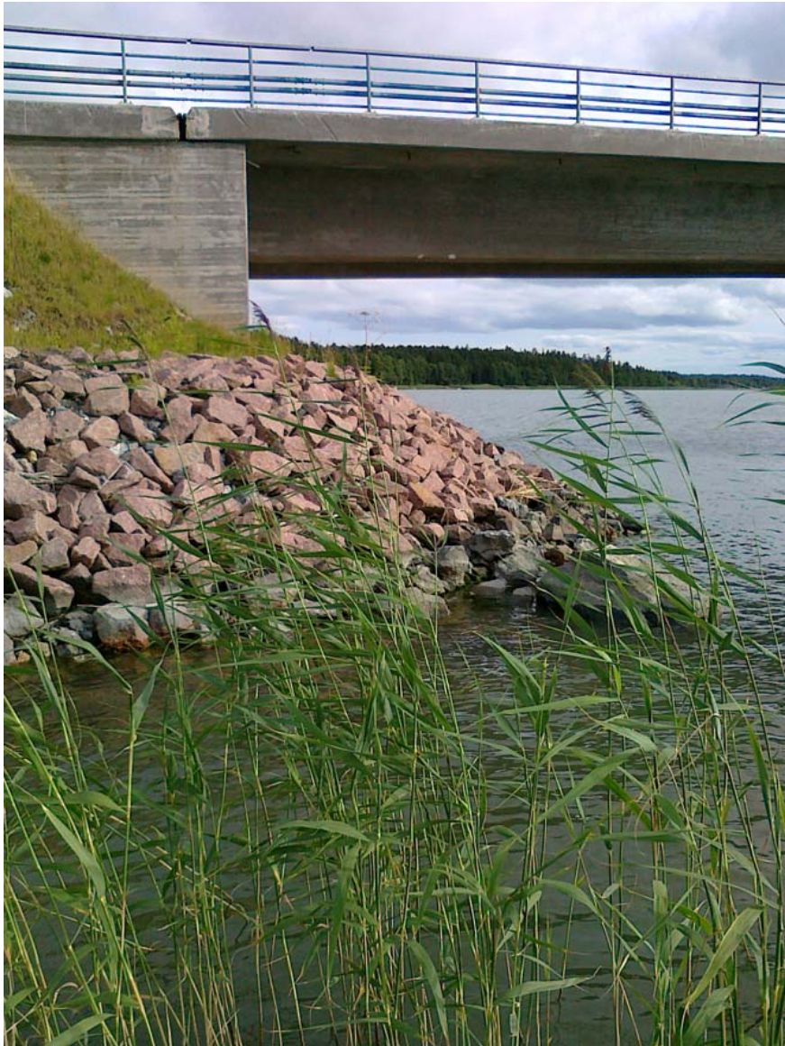
Kuva. Kiviheitoke suojaa rakenteita aallokon vaikutuksilta. Taivassalo.
