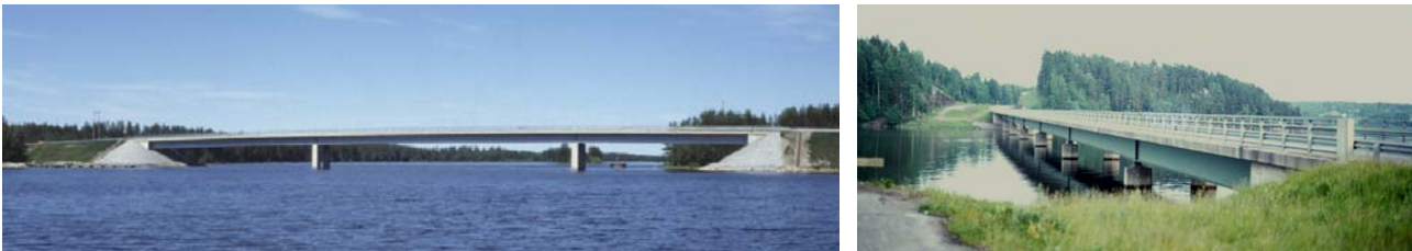
Silta oikealla on liian lähellä vesipintaa, ohut laattasilta olisi parempi ratkaisu.
