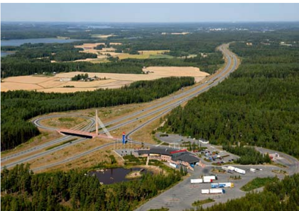
Lipon risteyssilta Akaassa valtatiellä 3.
