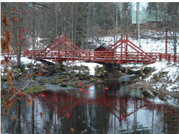
Puiset ansarakenteet sopivat kevyelle liikenteelle ja painoltaan rajoitetulle ajoneuvoliikenteellekin. Oikealla Myllysilta Nurmijärvellä, joka on museosilta.
