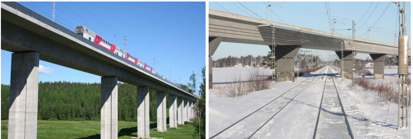
Rautatien kotelopalkkisilta ulokkein ja kaukalopalkkisilta ilman ulokkeita.
