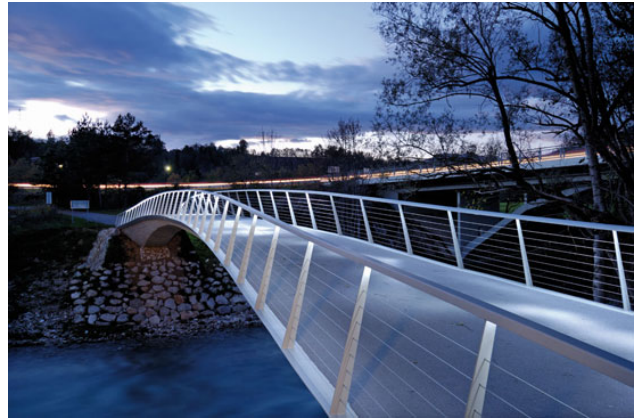
Kaksi kaarevaa kevyen liikenteen siltaa joen yli. Vasemmalla Viikinmäen kevyen liikenteen silta ulkoilualueella Helsingissä Vantaanjoen ylitse. Se on puukantinen terässilta ja pituus 50 m. Viereisen kuvan silta betonista.
