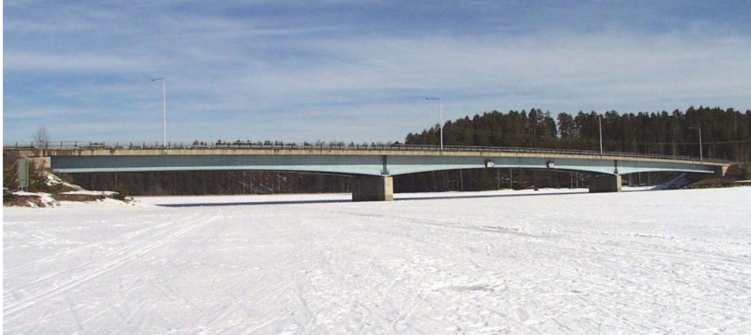
Kulkuaukkoa voidaan korostaa tekemällä se muita pidemmäksi ja myös käyttämällä viisteitä päällysrakenteessa. Ukonsalmen silta Ruokolahdella.
