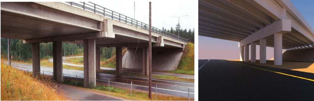
Monikerroksisen risteyksen lukuisten pilarien ja moottoritien ajoratojen väliin tulevan välituen onnistuneita ratkaisuja.
