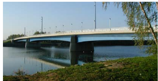
Parillista aukkomäärää tulisi välttää, että kulkuaukko sillassa erottuisi helposti.
