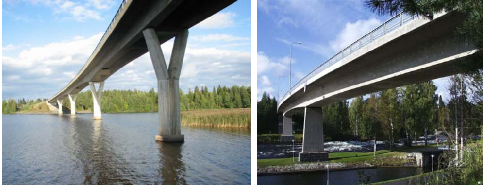
Kaksi tapaa saada aikaan läpinäkyvyyttä: Yläpään kehäsysteemi ja kannen pitkät ulokkeet. Akkalansalmen silta, Lapinlahti ja Karvion silta, Heinävesi
