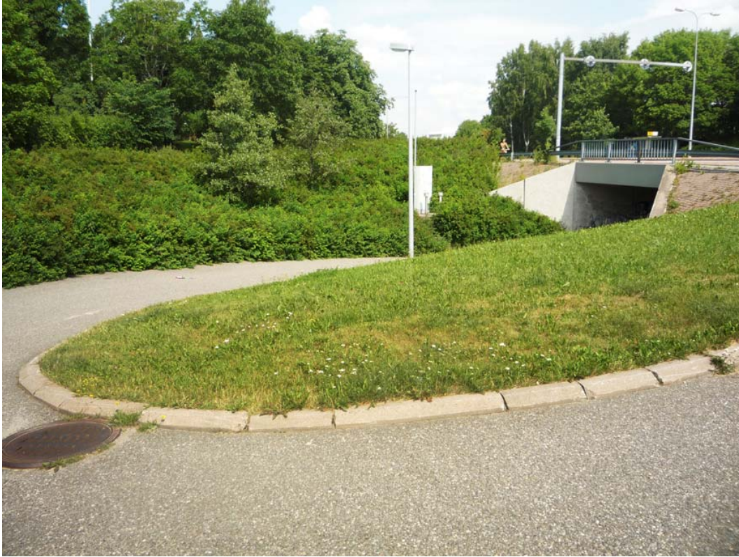
Kuva. Rakennetussa ympäristössä sijaitsevan alikulun jyrkimmät luiskat on verhoiltu betonikivellä ja istutuksilla, loivimmassa luiskassa on nurmetus. Näkemäalue on jätetty vapaaksi istutuksista. Turku.
