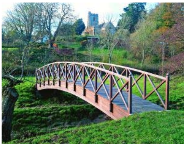
Puinen palkki- ja riippusilta kevyelle liikenteelle. Ristikko kaiteena ja jäykistämässä riippusiltaa. Perttilän silta oikealla on museosilta.
