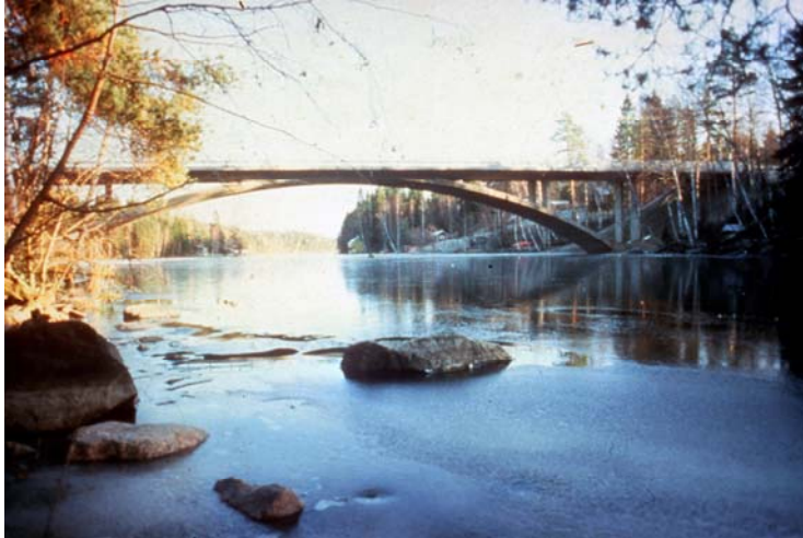
Kaitaveden silta, Tampere; aukko n. 75 m leveä ja 8 m korkea.
