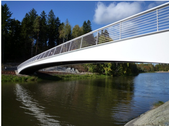
Kaksi kaarevaa kevyen liikenteen siltaa joen yli. Vasemmalla Viikinmäen kevyen liikenteen silta ulkoilualueella Helsingissä Vantaanjoen ylitse. Se on puukantinen terässilta ja pituus 50 m. Viereisen kuvan silta betonista.
