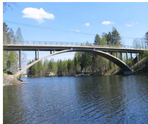
Kurkelan silta, Liedossa tasaisessa peltomaisemassa ja Lapinsalmen silta, Kuopiossa mäkisessä metsämaisemassa.
