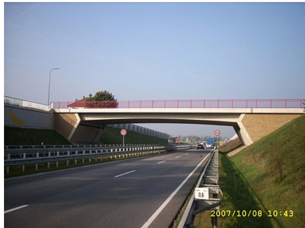
Suora ja vinoseinäinen kehäsilta. Oikean puolisessa kuvassa aukko on avara ja näkyvyys tiellä hyvä.
