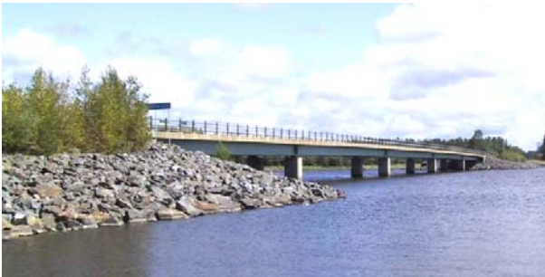
Kun aukot ovat samansuuruisia, kulkuaukko ei erotu ja silta tekee vaatimattoman vaikutelman. Viisteellinen aukko osoittaa väylän ja antaa siltaan ilmettä. Hyvät mittasuhteet, mm palkin korkeuden suhde jännemittaan ja alikulkukorkeuteen ovat aina tärkeitä.
