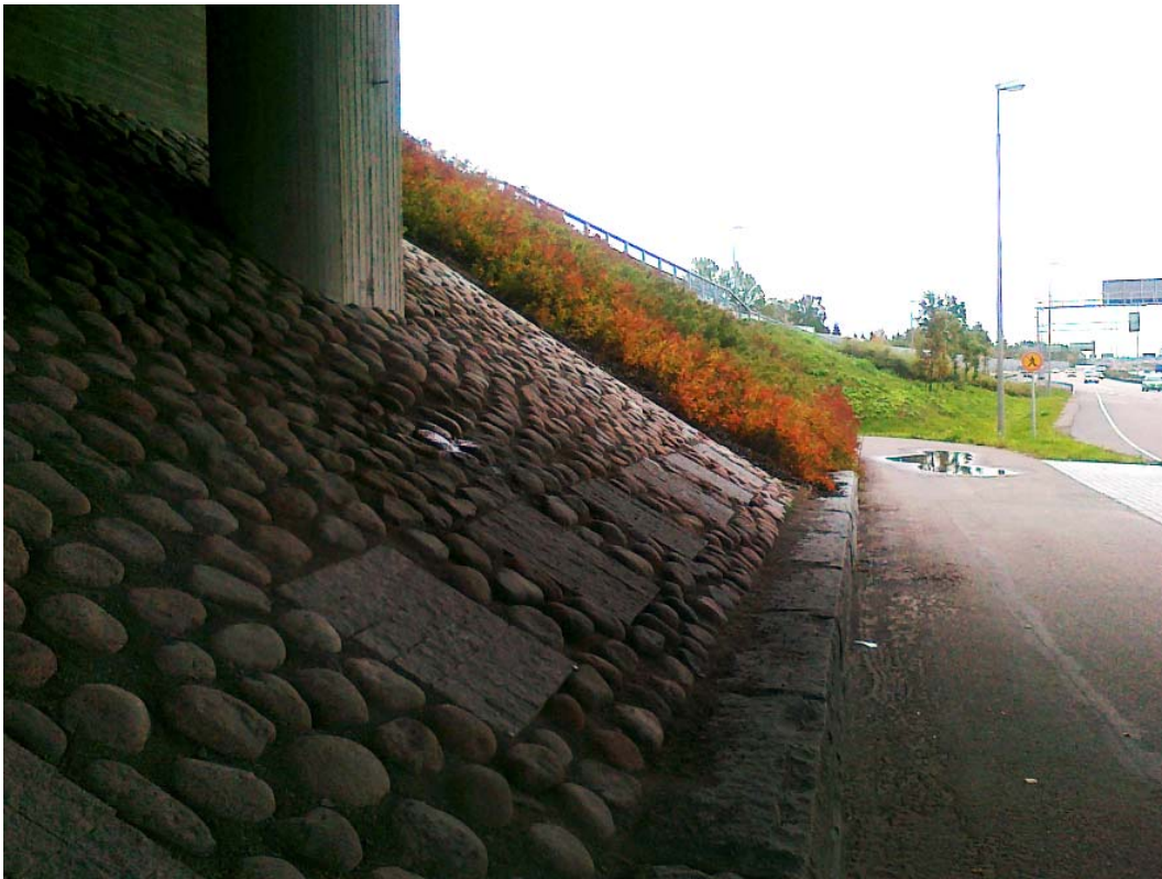
Kuva. Tukimuriin tuettu kenttäkiviverhous risteyssillan etuluiskassa. Vantaa.
