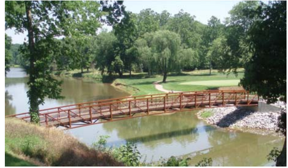
Ympäristöön sopivia kevyen liikenteen puusiltoja. Vasemmalla kaupungin puistomaisella alueella oleva Ollaksen puusilta Espoossa erottuu helposti tiemaisemassa. Oikealla kevyt ristikkosilta.
