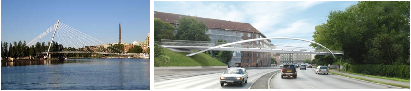
Epäsymmetrisiä ratkaisuja yläpuolisin rakentein. Vasemmalla Laukon silta Tampereella.
