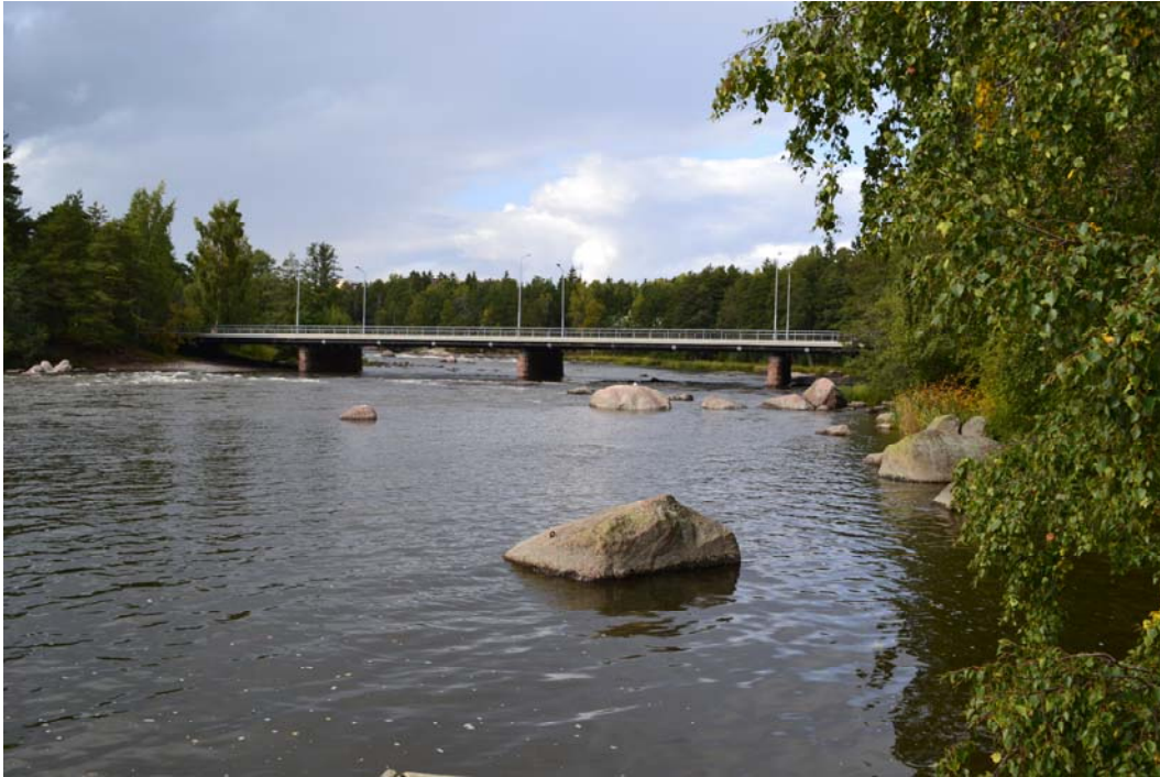
Langinkosken silta Kotkassa on arvokkaassa koskimaisemassa keisarin entisen kesämajan lähellä. Silta on sovitettu taitavasti maisemaan ohuena jännitettynä laattana kivisin pilarein ja riittävän kaukana kesämajasta, ettei sen lähiympäristö häiriinny.
