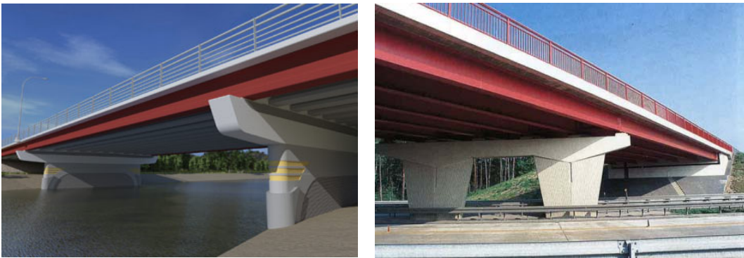
Elementtisiltojen pilariden suunnittelussa on tärkeää, että kannen jatkuvuus saadaan näkymään. Kaiteet, reunapalkit ja palkkien väri korostavat myös jatkuvuutta. Pilarien poikkipalkki ylemmissä kuvissa aiheuttaa epäjatkuvuutta. Myöhemmin kohdassa elementit lisää ratkaisuja.
