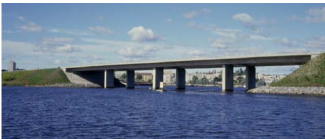
Parillista aukkomäärää tulisi välttää, että kulkuaukko sillassa erottuisi helposti.
