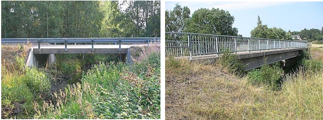
Laatta- ja palkkisilta elementeistä.
