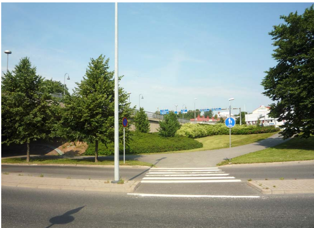
Kuva. Siltaan liittyviä luiskia on saatu loivennettua tukimuurilla. Hyvin hoidetut istutukset liittävät sillan kaupunkiympäristöön jättämällä kuitenkin keskeiset rakenteet näkyviin. Turku.
