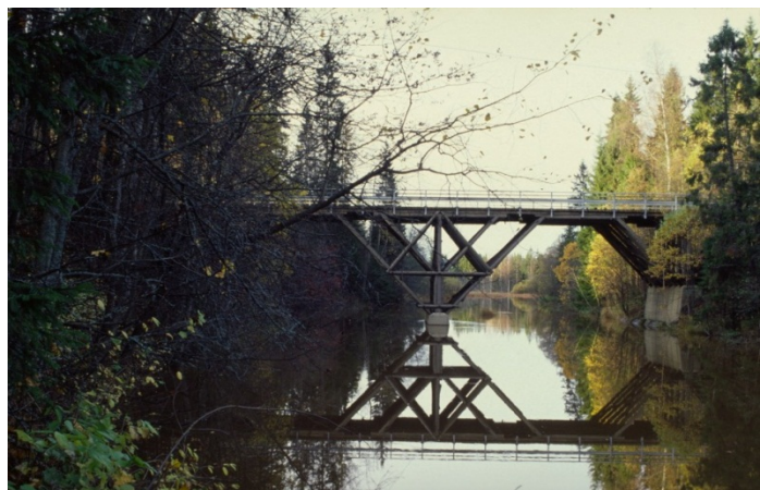
Puiset ansarakenteet sopivat kevyelle liikenteelle ja painoltaan rajoitetulle ajoneuvoliikenteellekin. Oikealla Myllysilta Nurmijärvellä, joka on museosilta.
