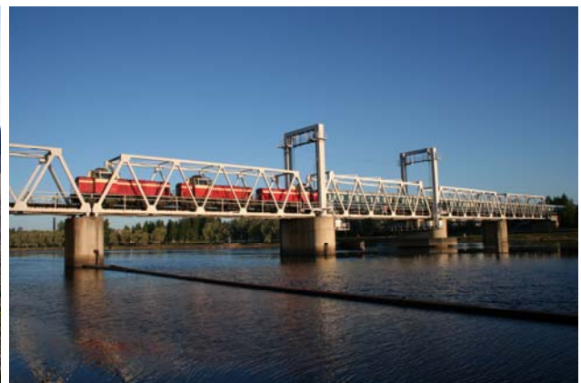
Joensuun ratasilta, jossa nostosiltaosa vesiliikennettä varten
