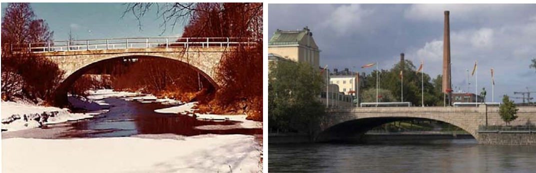
Oikealla on Hämeensilta Tampereella, yksinivelinen holvi betonista, verhoiltu graniitilla. Vasemmalla kolminivelinen holvi. Sillat ovat massiivisia.
