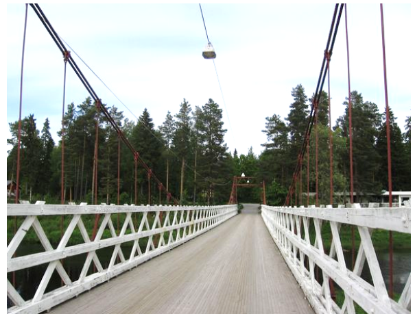
Puinen palkki- ja riippusilta kevyelle liikenteelle. Ristikko kaiteena ja jäykistämässä riippusiltaa. Perttilän silta oikealla on museosilta.
