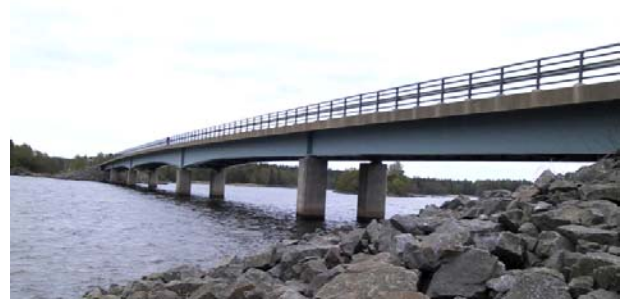
Kun aukot ovat samansuuruisia, kulkuaukko ei erotu ja silta tekee vaatimattoman vaikutelman. Viisteellinen aukko osoittaa väylän ja antaa siltaan ilmettä. Hyvät mittasuhteet, mm palkin korkeuden suhde jännemittaan ja alikulkukorkeuteen ovat aina tärkeitä.
