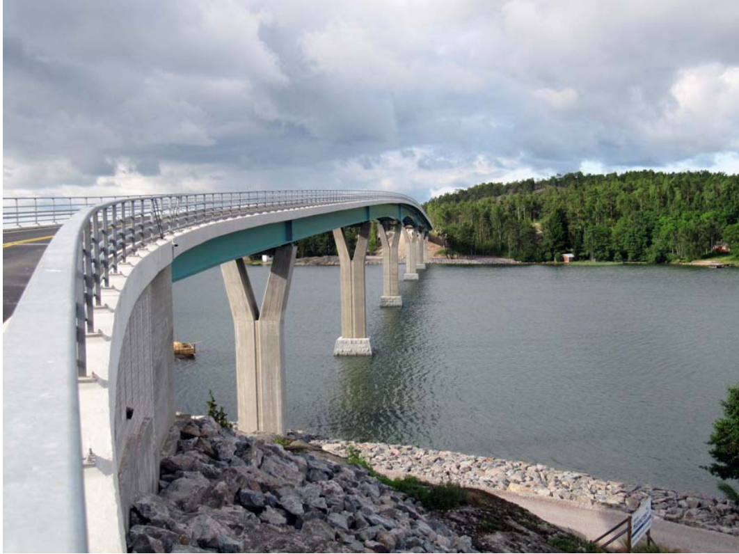
Kuva. Korkean sillan pengerluiskaa on saatu pienennettyä maatuon muotoilulla. Luonnonympäristössä on käytetty kiviheitokeverhoilua. Lövä, Kemiönsaari.
