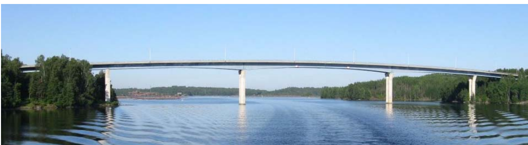
Luukkaansalmen silta, Lappeenranta; kulkuaukko 120 m ja korkeus 25 m.
