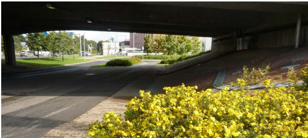
Kuva. Risteyssillan alittavan kevyen liikenteen väylän ympäristöä on elävöitetty betoniki- vetyn etuluiskan rauhallisella kuvioinnilla.
