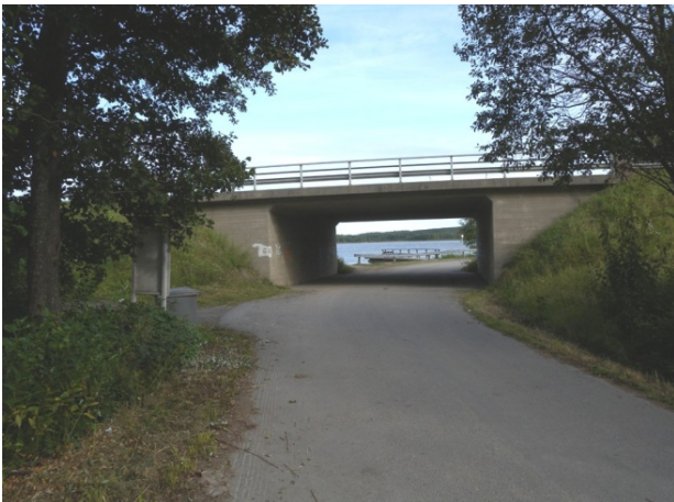
Suora ja vinoseinäinen kehäsilta. Oikean puolisessa kuvassa aukko on avara ja näkyvyys tiellä hyvä.
