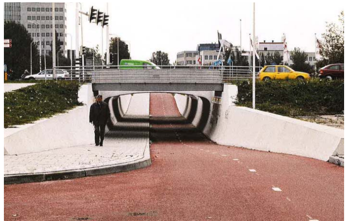
Aukon koon, muotoilun ja viimeistelyn suunnittelu paikan arvon ja liikenteen määrän mukaan. Esimerkkejä yksilöllisesti suunnitelluista alikulkukäytävistä keskeisissä kaupunkikohteissa. Valoaukko pitkässä alikulkukäytävässä lisää turvallisuutta ja viihtyvyyttä.
