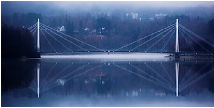
Ylistön kevyenliikenteen silta Jyväskylässä, aukko n. 100m
