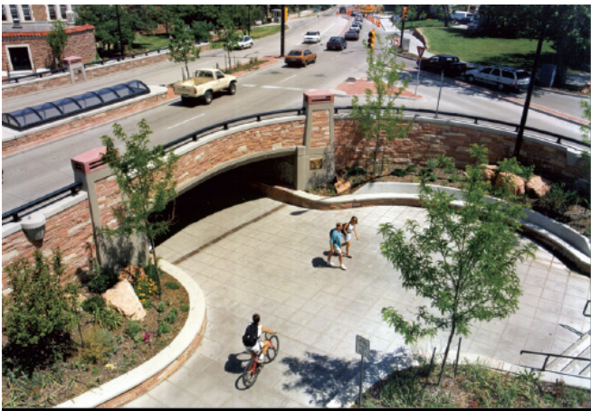
Aukon koon, muotoilun ja viimeistelyn suunnittelu paikan arvon ja liikenteen määrän mukaan. Esimerkkejä yksilöllisesti suunnitelluista alikulkukäytävistä keskeisissä kaupunkikohteissa. Valoaukko pitkässä alikulkukäytävässä lisää turvallisuutta ja viihtyvyyttä.
