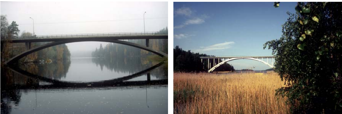
Kevyt, avoin holvisilta ja sauvakaarisilta. Oikealla Sattmarkin silta Paraisilla.
