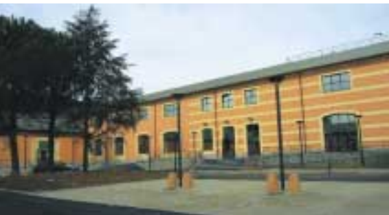
Nell'edificio che ospita il Posto centrale lavorano sette addetti all'Scc
