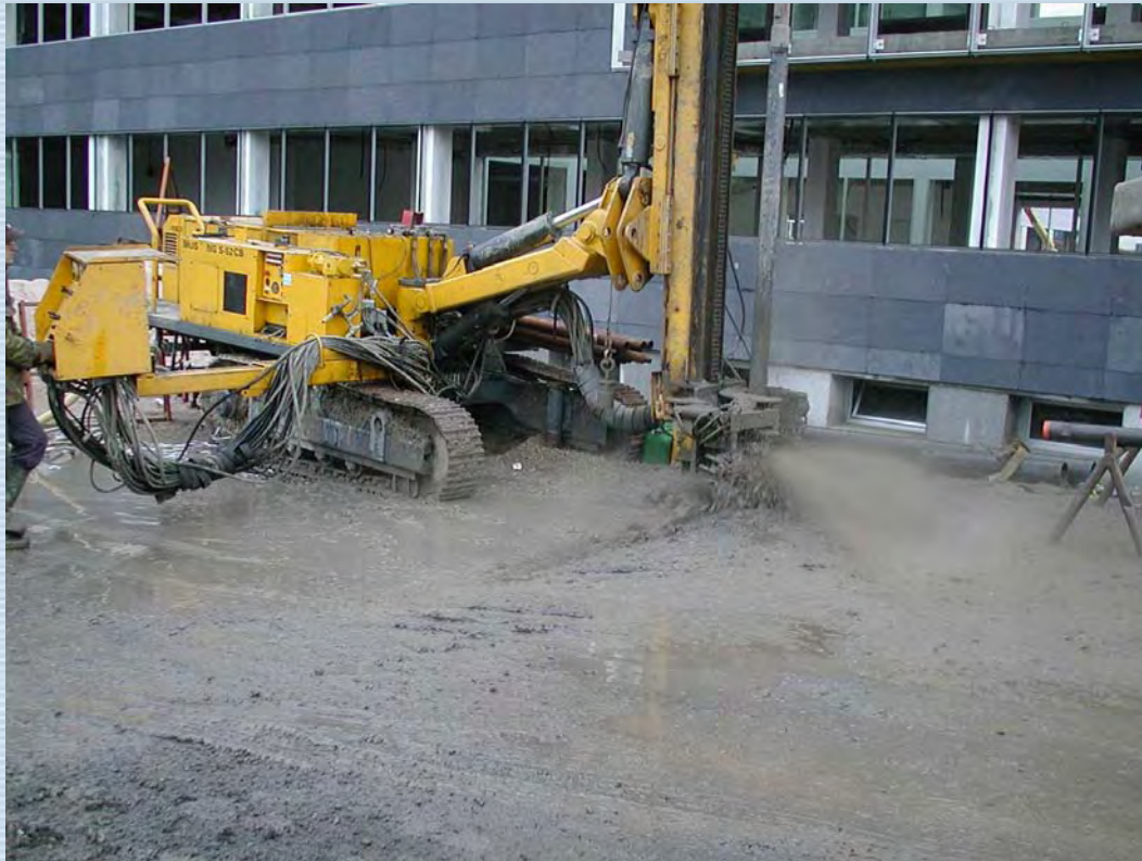
PERFORACIÓN SONDEO PILOTO. FEBRERO DE 2005
