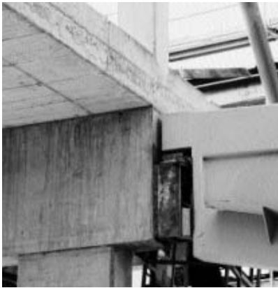
2 Glasdach über dem Atrium – schwimmend gelagert
