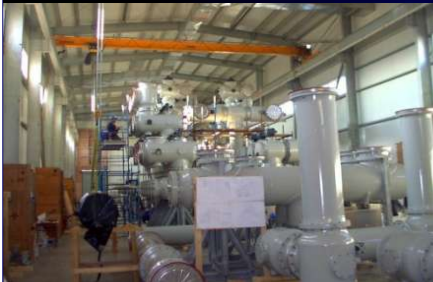
Montage poste blindé 400KV Hassi Ameur
