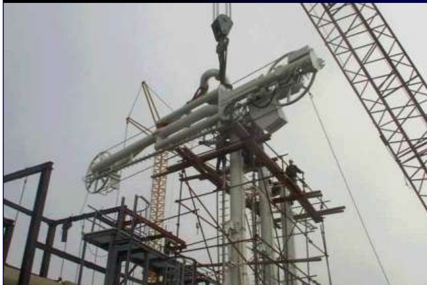
Montage Bras de chargement (GL4Z Arzew)
