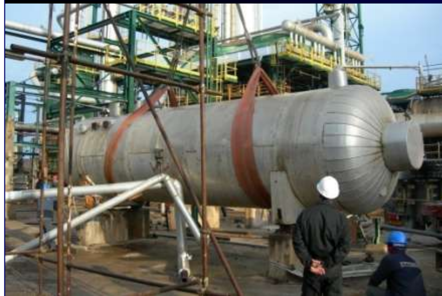
Démontage de l'Unité 400, Raffinerie de Skikda
