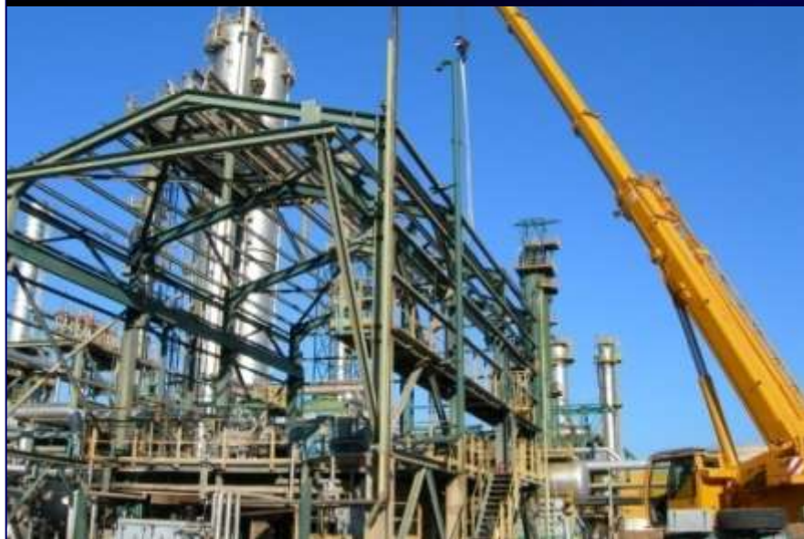
Démontage de l'Unité 400, Raffinerie de Skikda
