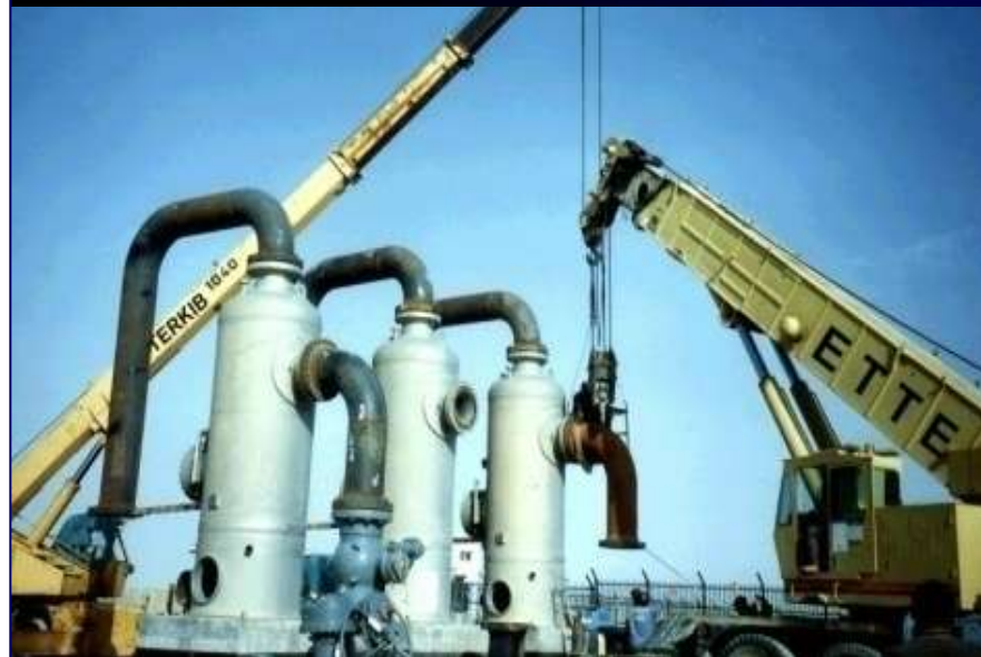
Montage des filtres (GK2 42"- HRM et Skikda)
