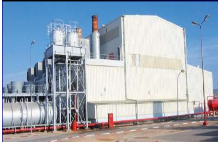
Centrale (5x8MW Diesel) de Bechar
