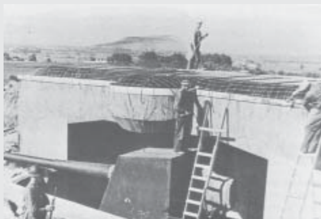
Denna bild från de avslutande arbetena på pjäsvärnen med pjäsen redan monterad, bör vara tagen omkring den 20 maj 1940
