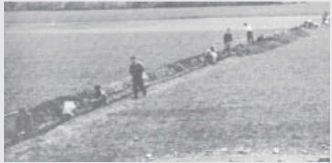
Grävning av kabelgravar
