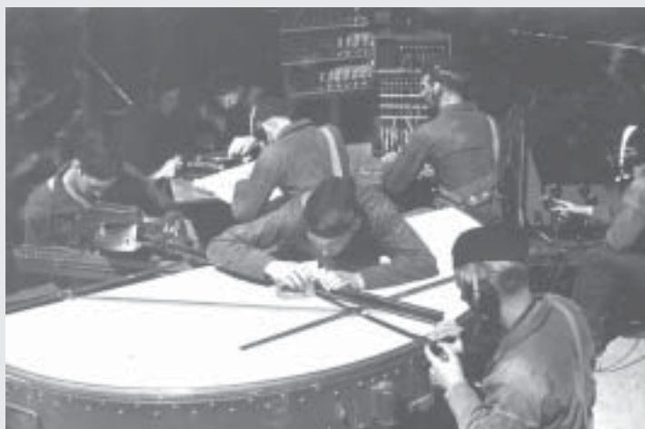
Skjutbord m/33-37 användes för omräkning av bäring och avstånd från mätstation utanför batteriet till att gälla från batteripunkten. Pjäs i batteripunkt erhöll sidriktning och uppsättning. Omräkning för pjäser som inte stod i batteripunkten skedde med hjälp av pjäsparallaxtavla vid respektive pjäs
