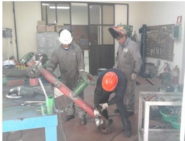
Fig.63 – Cambio de tubería de agua tipo 'T'.
