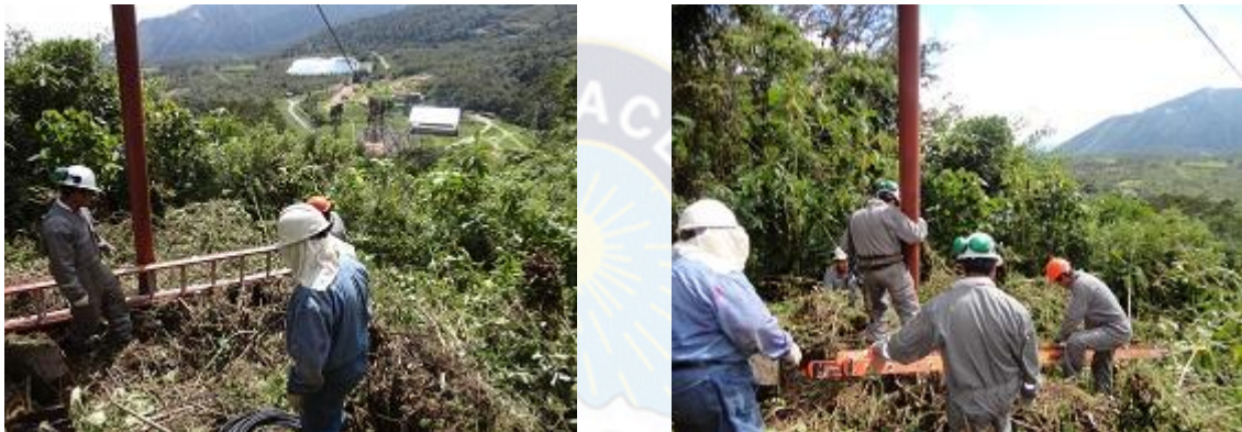
Fig.53 - Reparación de Cable de Viento Sujeción de Poste Línea 10kv.
