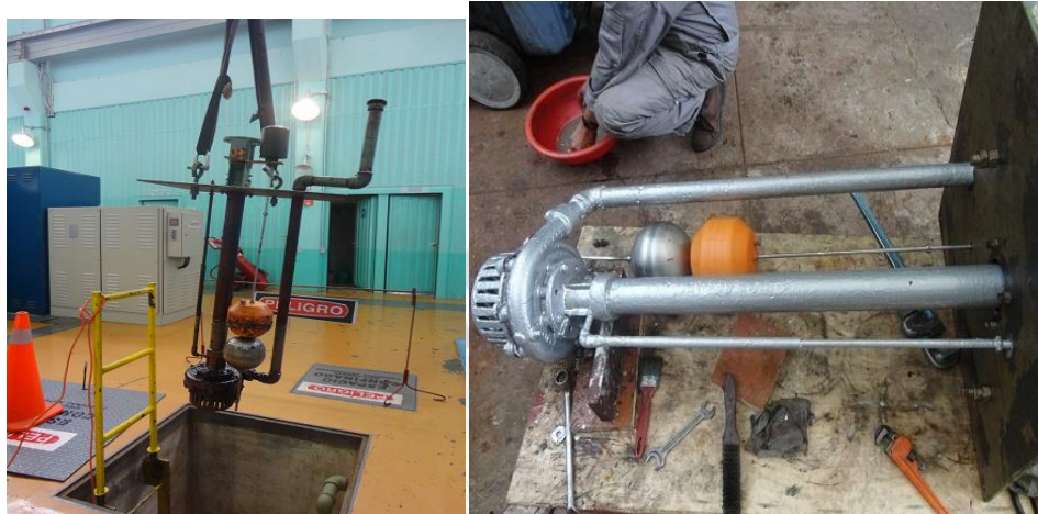
Fig.64 - Desmontaje de Bomba Sumidero y Pintado con Anticorrosivo
