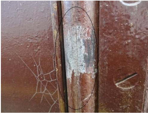
Fig.60 - Sello de Goma Deteriorado.
