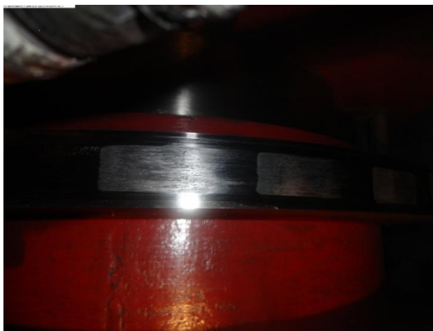
Fig.54 - Estado del Anillo Antes de la Rectificación.
