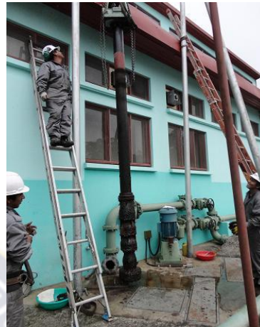
Fig.42- Desmontaje Bomba de Agua
