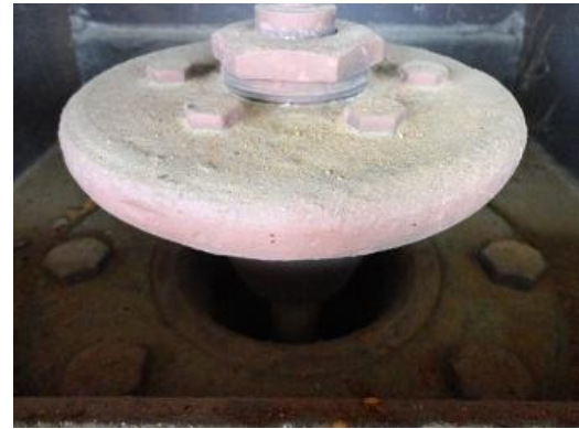
Fig.61 - Tapón de Válvula Bypass no Cierra Bien.
