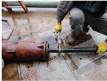
Fig. 45- Desajuste de Vástago y Turbinas de Bomba.
