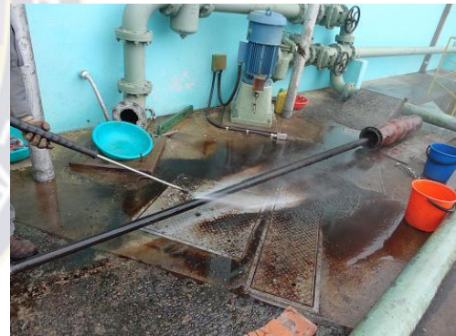
Fig. 44- Limpieza de Vástago
