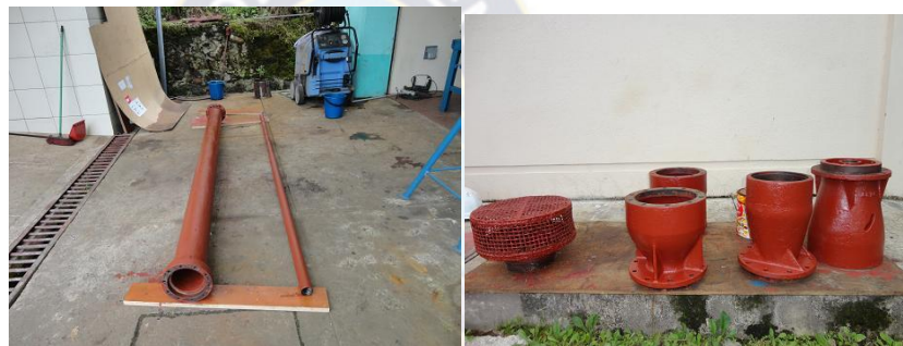
Fig.48- Pintado de Piezas con Anticorrosivo
