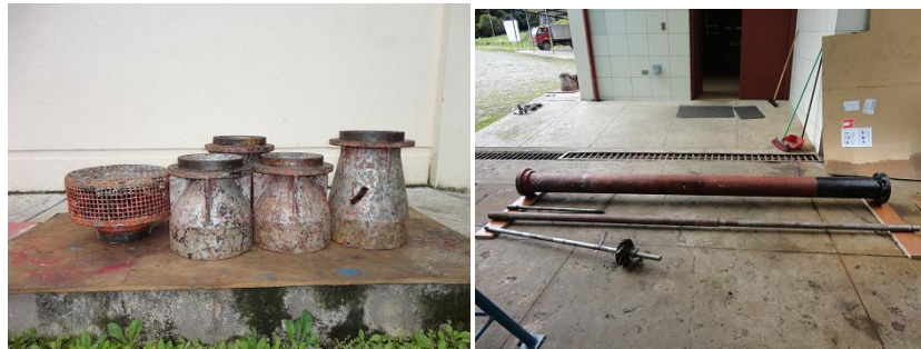
Fig.47 – Limpieza de Piezas de la Bomba
