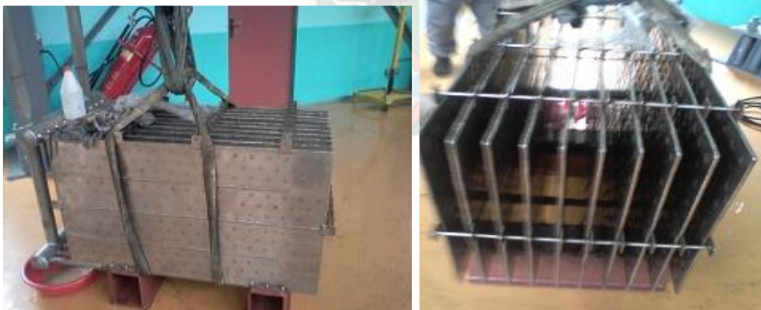
Fig.37 – Desmontaje de Radiador Enfriador de Aceite.
