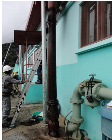
Fig.42- Desmontaje Bomba de Agua
