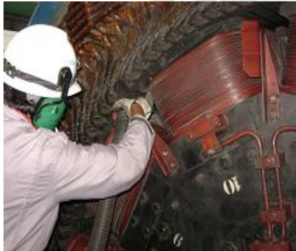
Fig.28 Limpieza de Generador.
