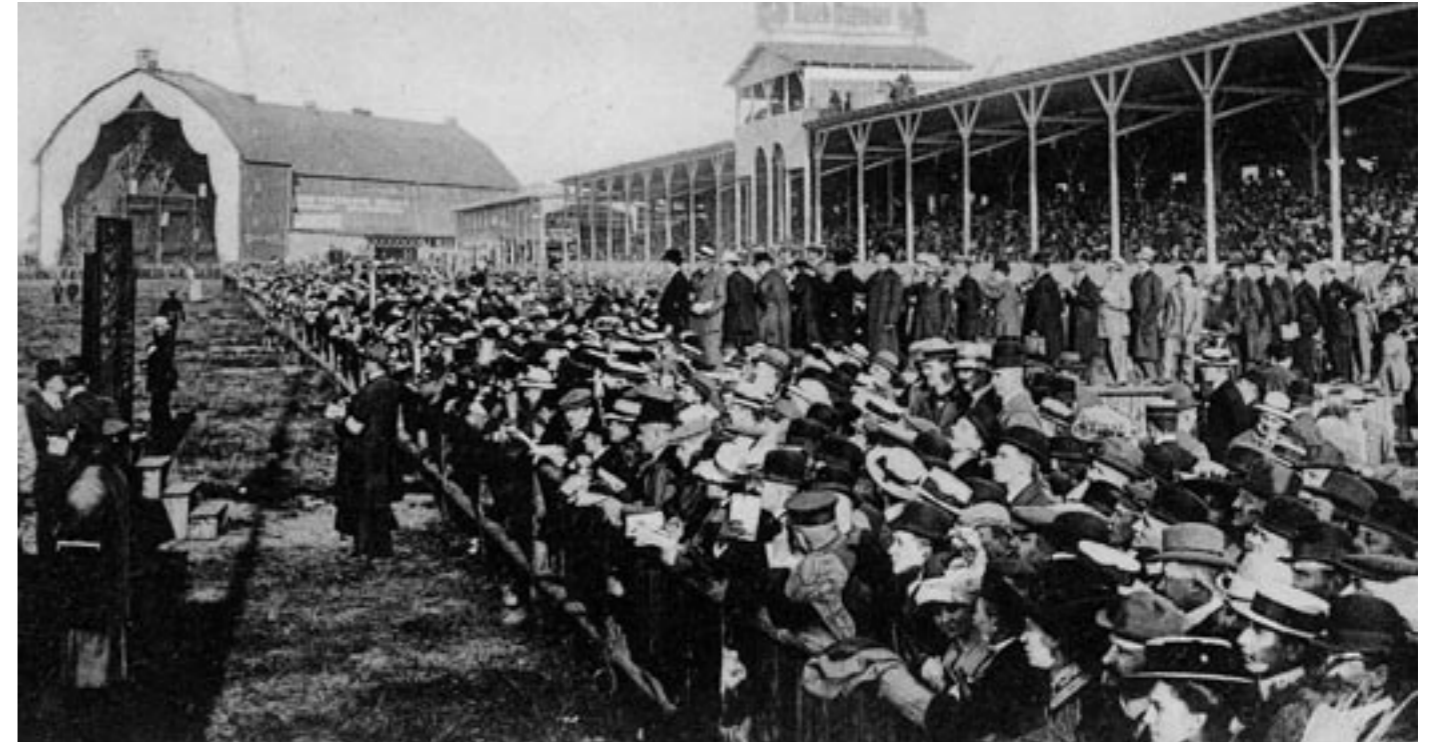
Die große Zuschauertribüne während einer Veranstaltung, im Hintergrund die von Arthur Müller errichtete Parseval-Luftschiffhalle.
