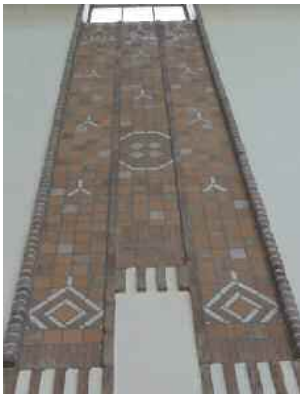
Fig. 50 Draperieën van terracotta in de Eloykerk (F.H. Klokke, 1950) in Oostburg.
