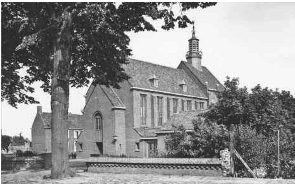
Fig. 69 De in 1998 gesloopte Nederlandse hervormde kerk in Sluis (J. Roodenburgh, 1950).
