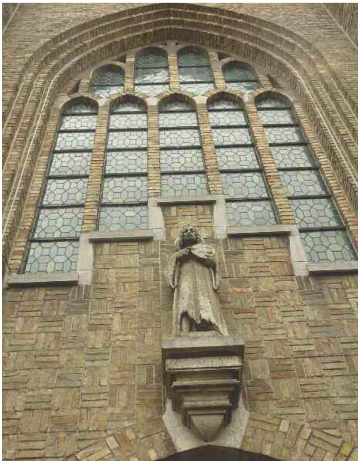
Fig. 17 De rooms-katholieke Sint Johannes de Doperkerk in Sluis (J. Oomen, 1927). Het gebouw is een opmerkelijk late creatie van de neogotiek. In de wederopbouw bleef men voor deze kerk trouw aan de neogotische bouwtrant, evenals in IJzendijke.
