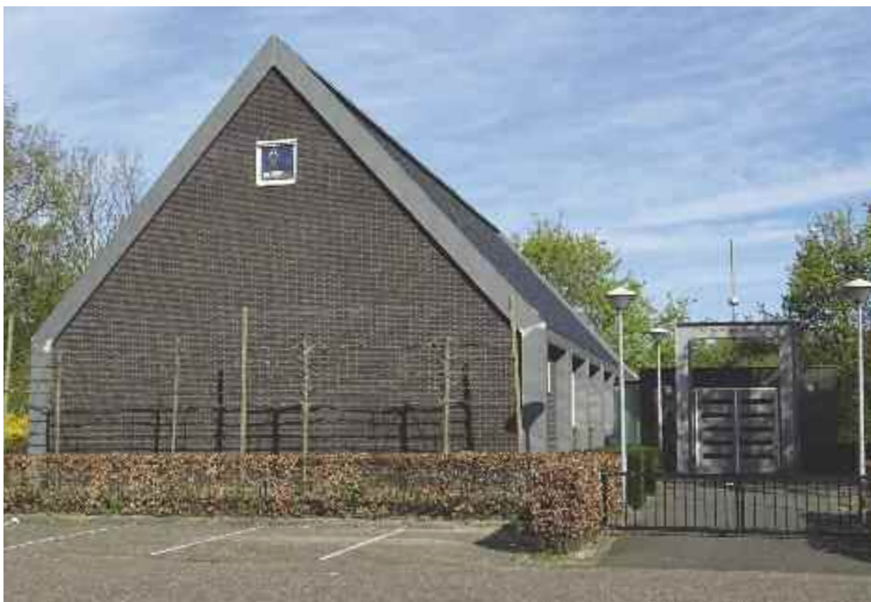
Fig. 25 De nieuwe kerkschuur van de Oud-Gereformeerde Gemeente in Terneuzen (Evertsenlaan 90, gebouwd in 2007 naar ontwerp van RoosRos Architecten).
