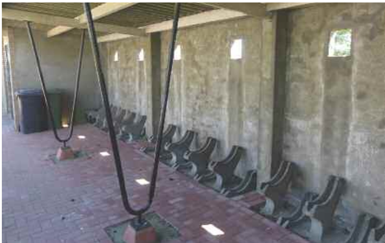
Fig. 35 Fietsenstalling behorende bij de Gereformeerde kerk in Anna Jacobapolder.
