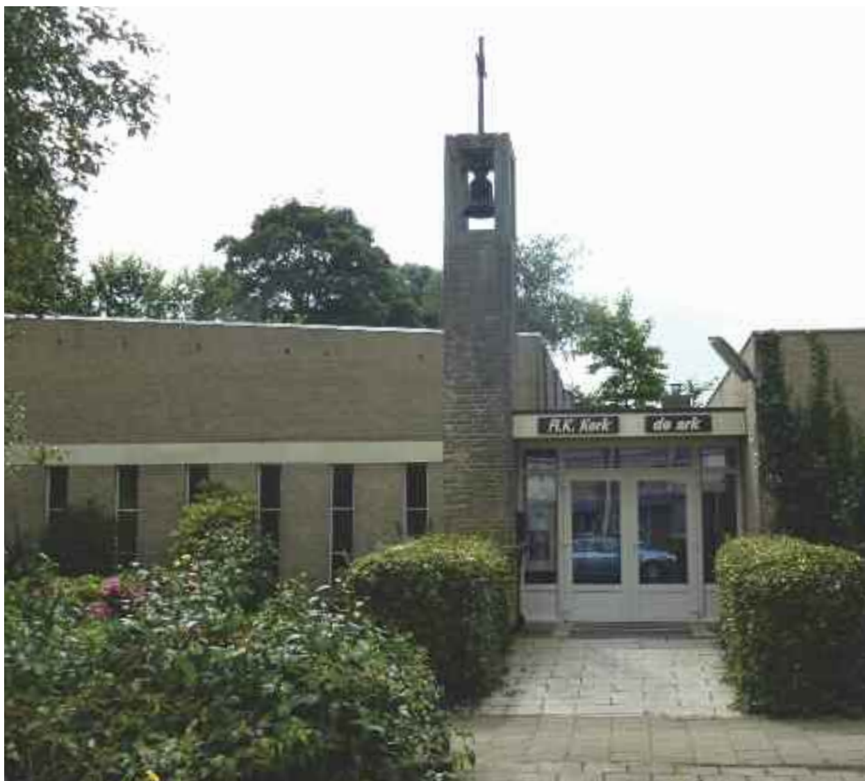
Fig. 41 De rooms-katholieke kerk De Ark in Rilland die in 2016 gesloopt wordt (P. Wolfs, 1969-1970).
