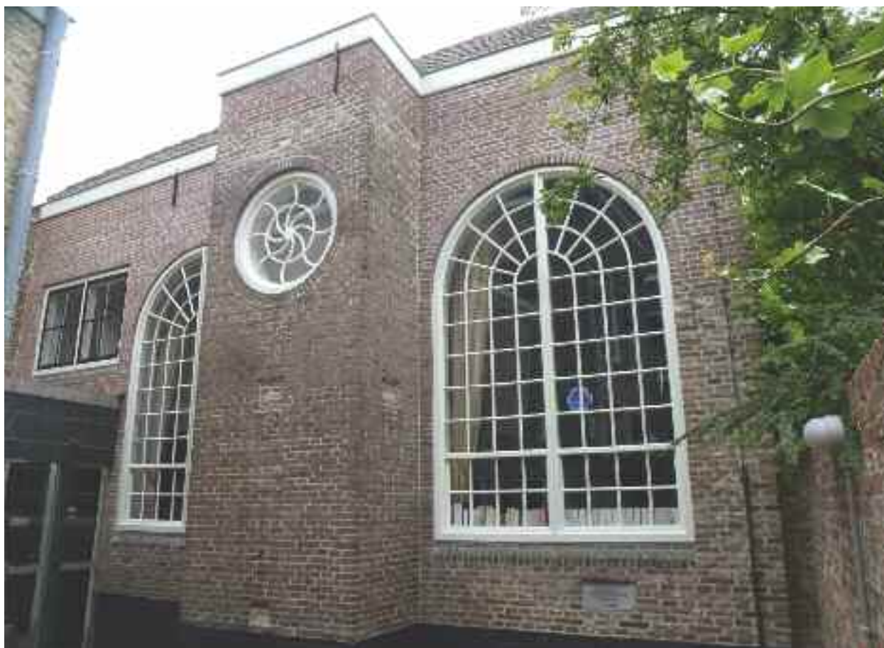
Fig. 62 De Joodse synagoge van Middelburg, het laatste religieuze gebouw in Zeeland dat na de verwoesting in de Tweede Wereldoorlog weer werd opgebouwd, maar pas in 1994.
