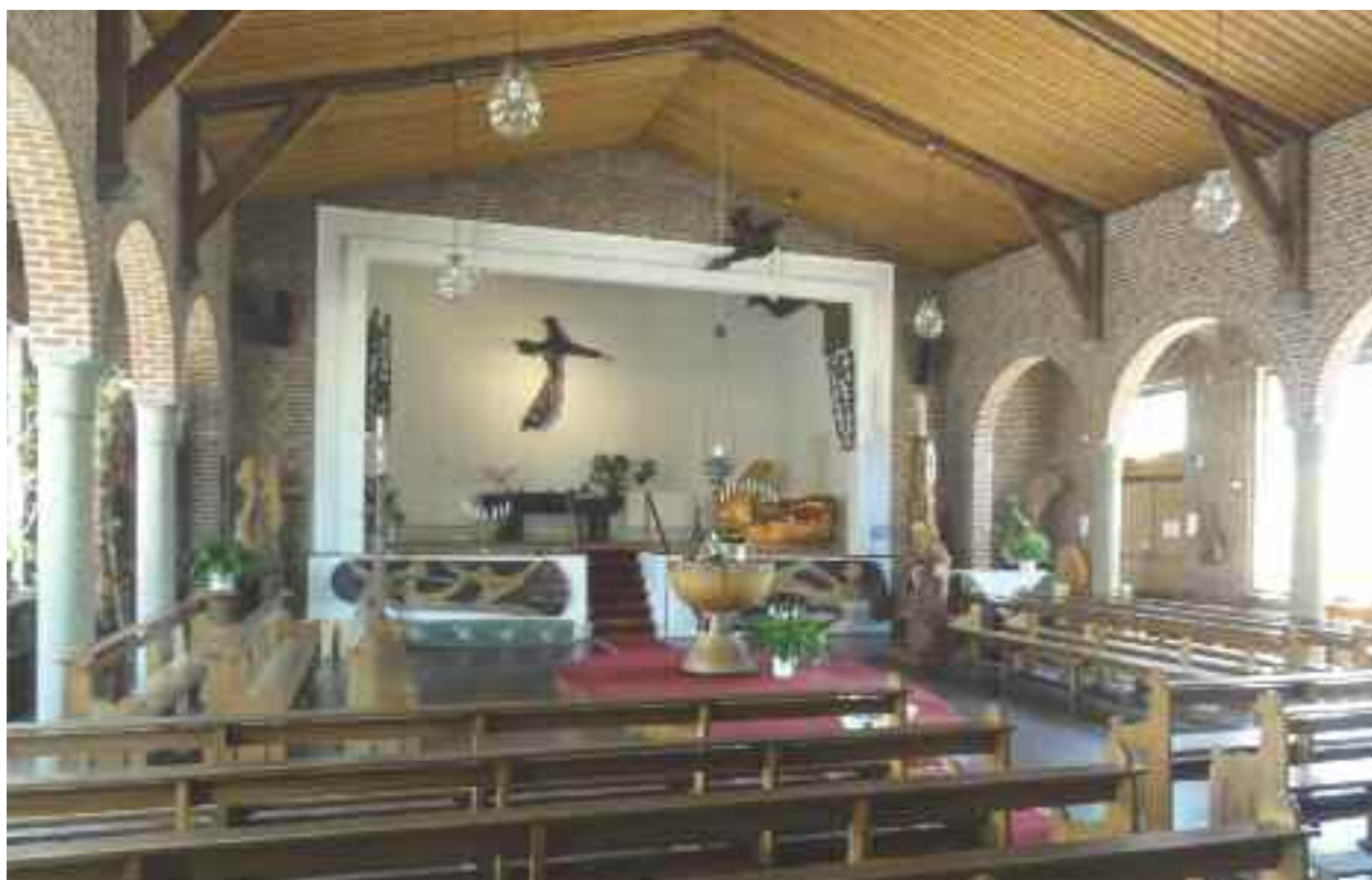
Fig. 44 De kleine kolommen tussen schip en zijbeuken in de Sint Barbarakerk (F.Mol, 1950) in Breskens van de kunstenaar-priester Omer Gielliet zijn een vroeg voorbeeld van een bijna terloopse betontoepassing.
