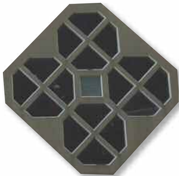
Fig. 40 Schokbetonnen venstertraceringen in de Hervormde kerk Zuidzande.
