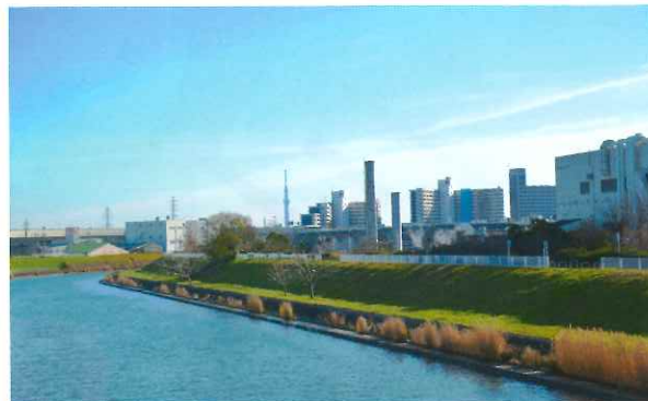
▲荒川をはさんで右手にあるのはUDトラックス川口工場跡（現在は凸版印刷川口工場）
