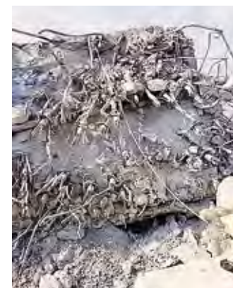
Si lavora tra le macerie
