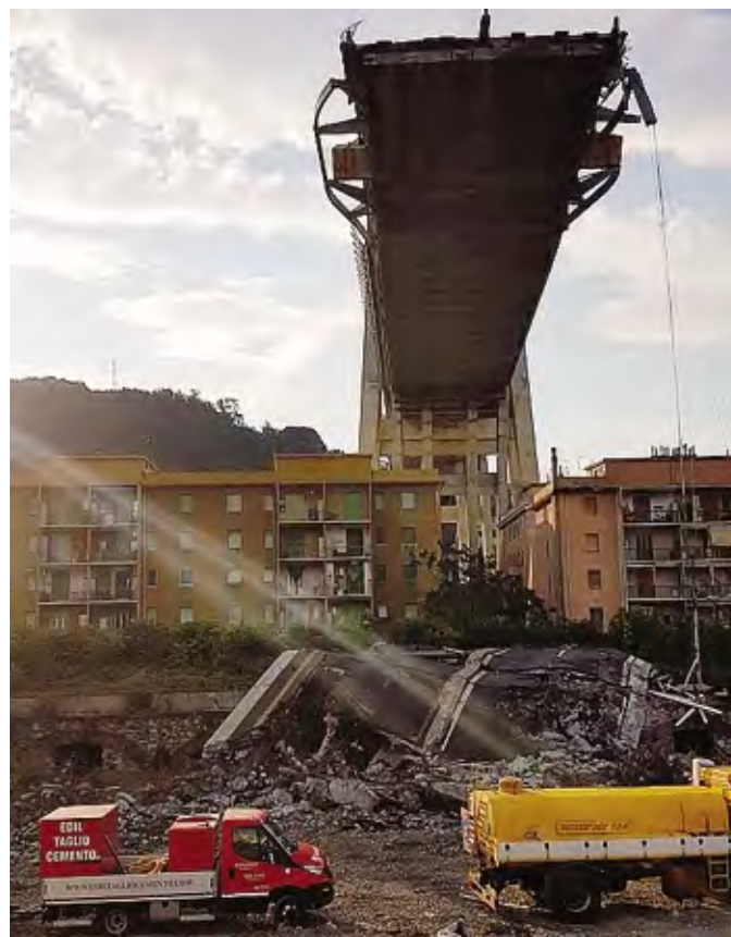
Un mezzo della Edil Taglio Cemento di Buglio sotto il ponte crollato
