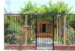
(8) Vivienda autoconstruida en el fondo de sitio con parrón y acceso vehicular.
