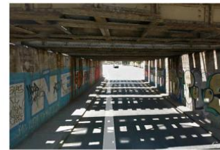
(6) Paso bajo nivel FFCC por Av. Antofagasta, sector muy hostil para el cruce peatonal.
