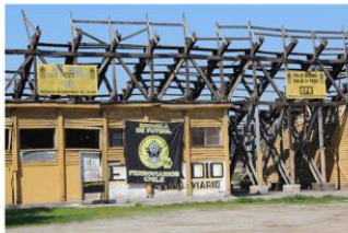
(15) Antiguas graderías de madera del Estadio San Eugenio. Fotografía tomada previamente a su demolición.
