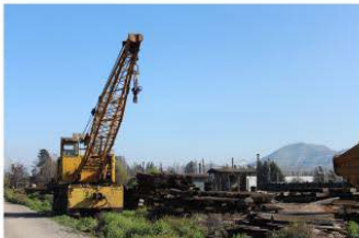
(13) Grúa al interior de la antigua Maestranza o Planta Soldadora Lo Chena. Al fondo se ve el Cerro Chena.
