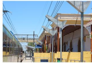
(1) Estación de San Bernardo cercada en su perímetro luego del terremoto del 27F (MH).
