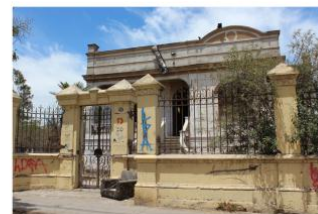
(2) Casona Ferrer abandonada, ocupada como morada para indigentes y recientemente incendiada por dentro (ZT).
