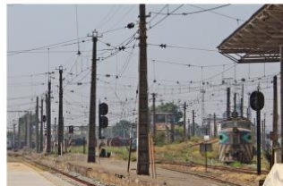
(1) Máquinas diesel en el sector de la antigua Maestranza Santiago, hoy patio de maniobras al sector poniente de la Estación Alameda.
