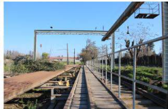
(16) Estructura para soldar rieles en Maestranza Lo Chena.
