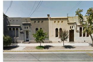
(14) Viviendas en fachada continua para maquinistas de FFCC en Población El Riel (ICH).
