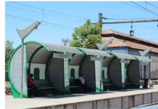
(3) Garitas instaladas para suplir el espacio de la Estación que se encuentra clausurado.
