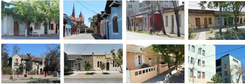
Fig.18: Imágenes de las poblaciones para ferroviarios construidas en el sector sur poniente de Santiago. De arriba abajo, izquierda a derecha, Población San Vicente, Padres Redentoristas, San Eugenio Vieja, El Mirador, El Riel, San Eugenio Nueva y Colectivos San Eugenio. Fuente: Propia.
