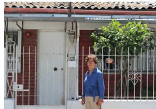
(5) Vivienda de albañilería reforzada autoconstruida en Población Fraternal Ferroviaria.
