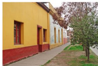
(1) Viviendas fachada continua en Pueblo de Lo Espejo (ZT).
