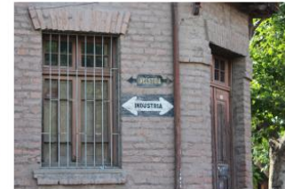
(20) Vivienda fachada conmina en Población Obrera Ferroviaria Sur, calle Industria.
