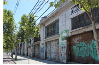
(10) Industrias, talleres y bodega por Av. Exposición, fuera del sector declarado ZCH.
