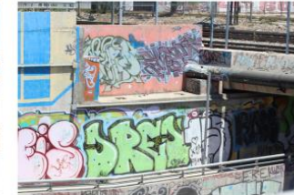
(8) Paso peatonal bajo nivel por Av. San José, poco utilizado dado lo inseguro que es. Los habitantes suelen cruzar por un paso a nivel informal.
