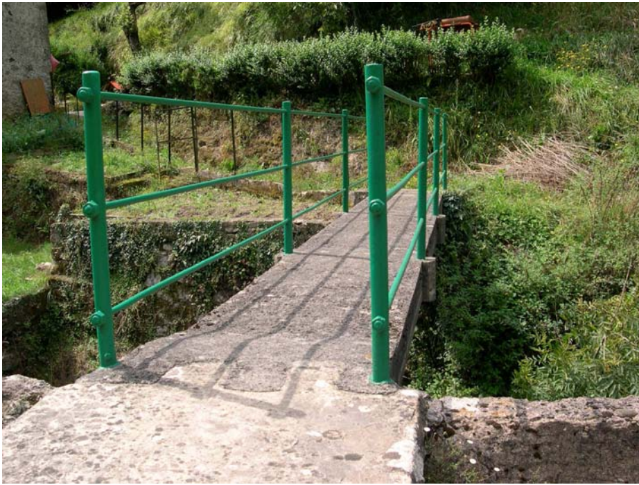
Pasarela de Motxogoxoneta.
