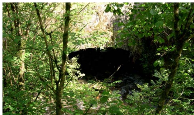
Puente nº 7 sobre regata de Albiztur.
