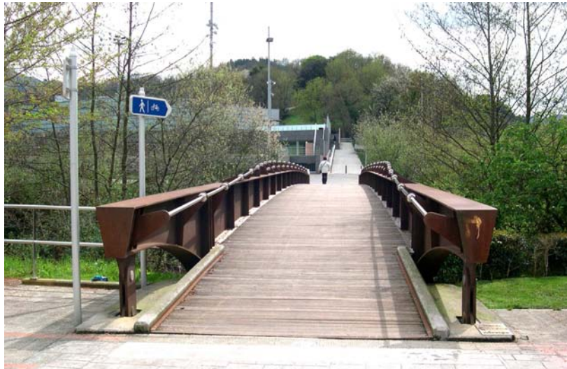
Puente del Polideportivo (1).
