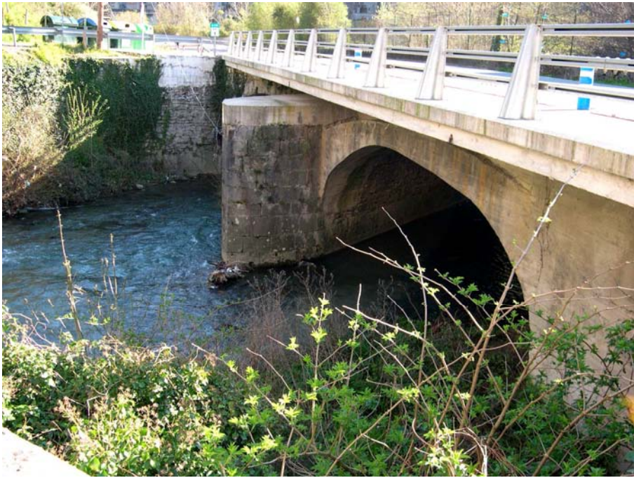
Puente de Txarama.
