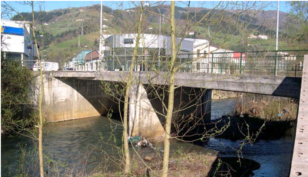
Puente de Usabal
