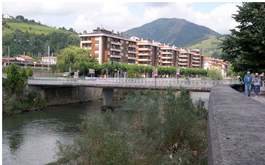
Puente de la S.A.M.
