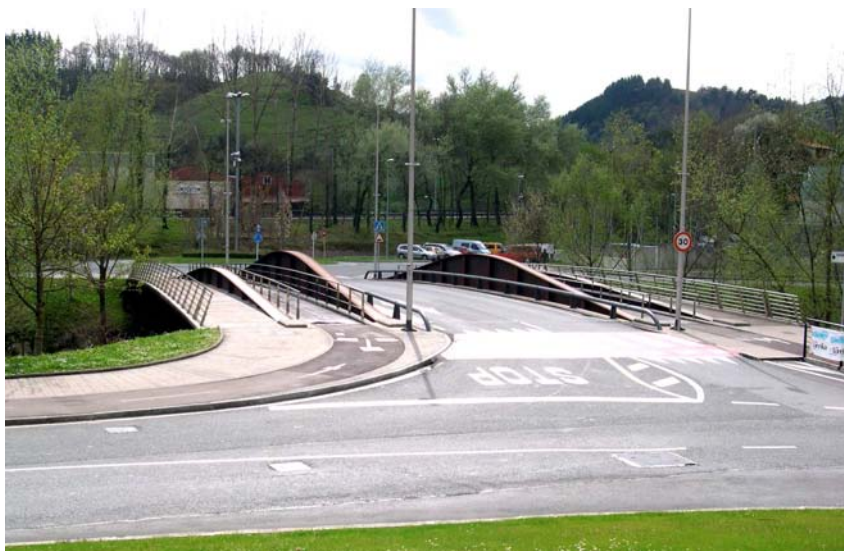
Puente del Polideportivo (2).
