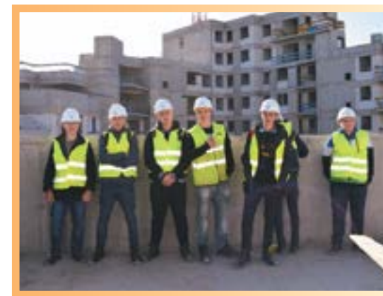
Wyjście na budowę
