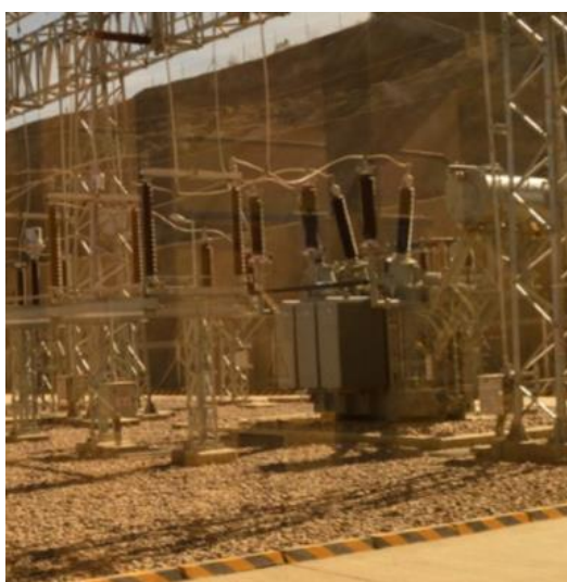
Transformador auxiliar
