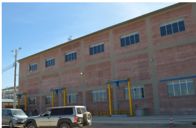
Vista edificio casa de máquinas Misicuni
