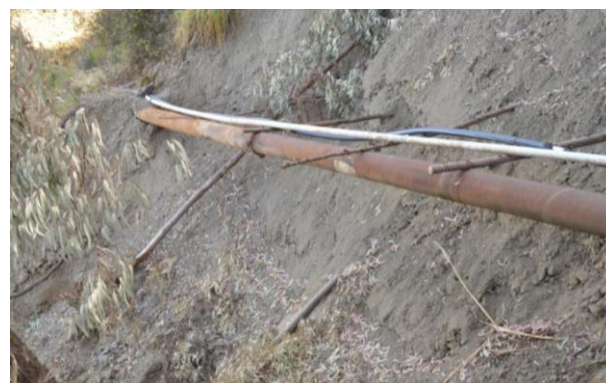
Deslave en la alimentación a riego
