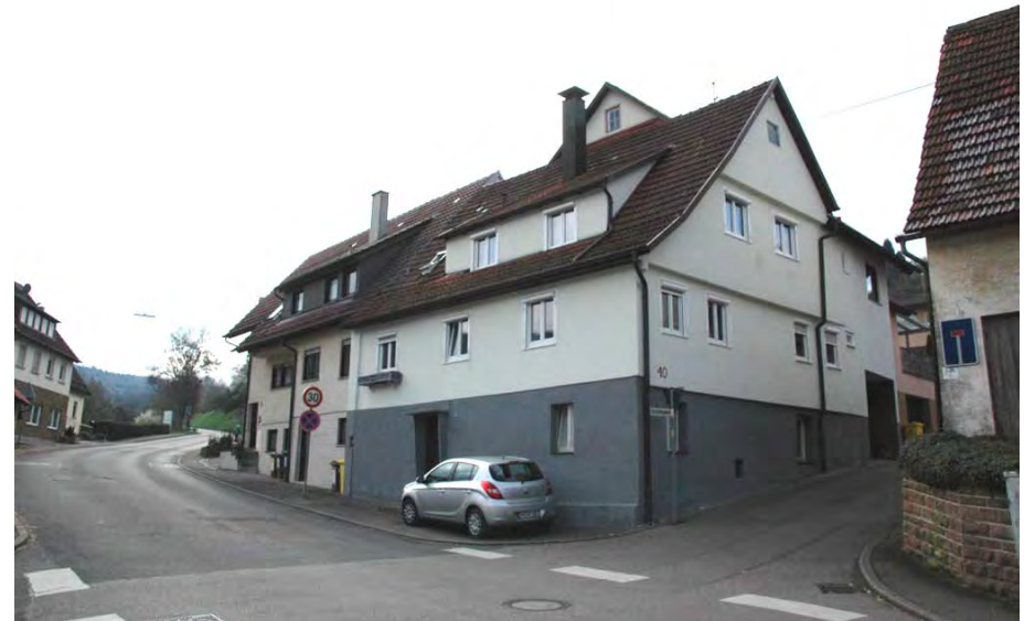
Ansicht gegen Nordosten
