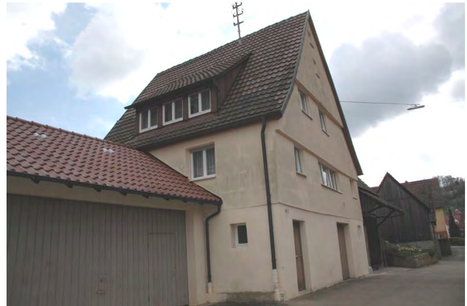
Eckansicht des Wohnhauses gegen Westen
