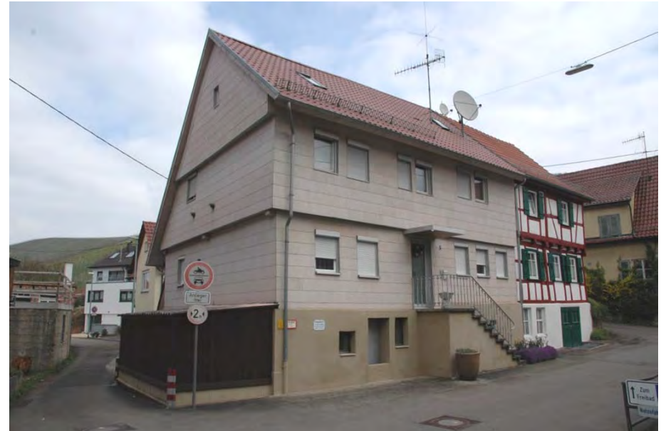
Ansicht gegen Süden. Nr. 3 (li) und Nr. 5 (re)
