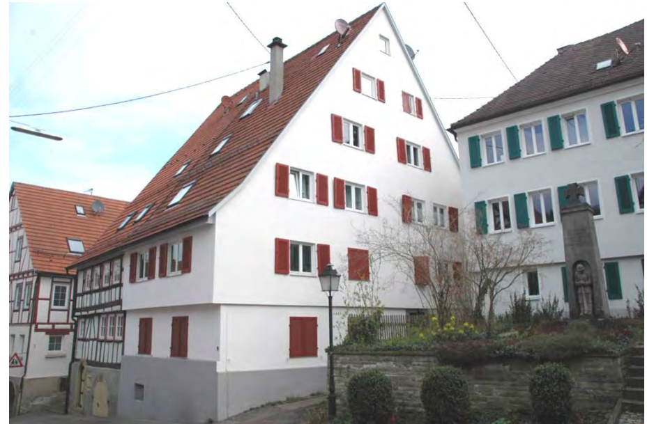
Gesamtansicht der erhaltenswerten Gebäude Hindenburgstraße 7 und 9
