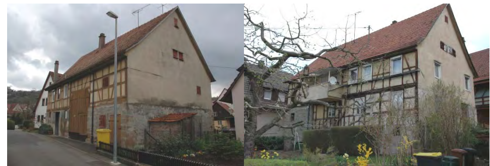
Ansicht gegen Nordosten
