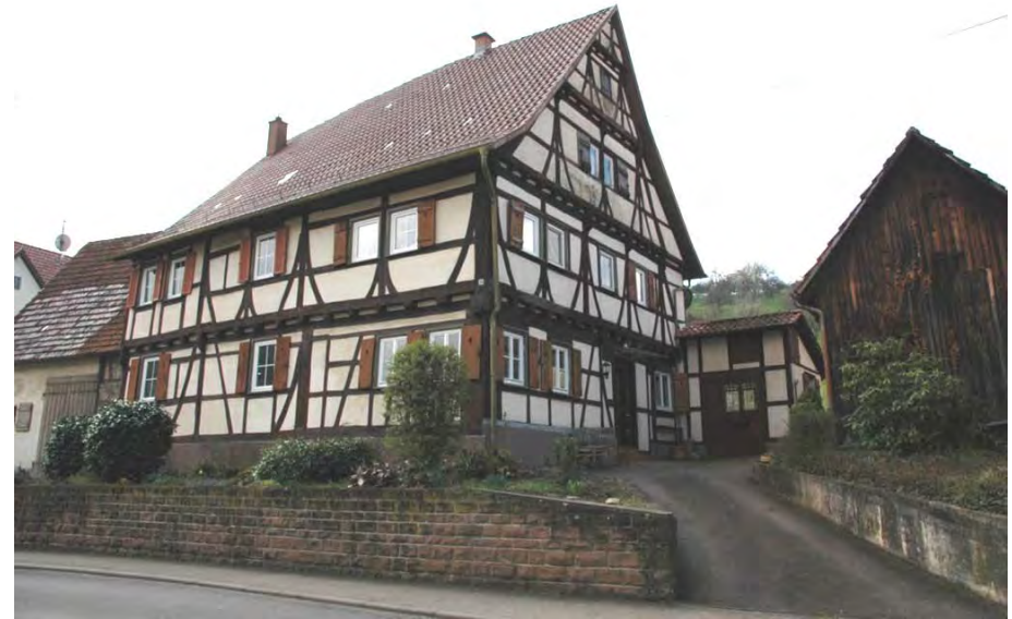
Ansicht gegen Nordosten
