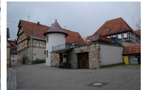
Gesamtansicht gegen Norden
