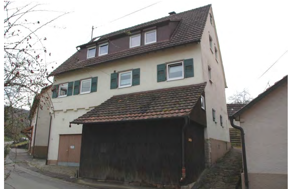
Blick auf die Nordfassade
