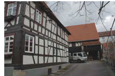
Blick auf die rückwärtige Scheune
