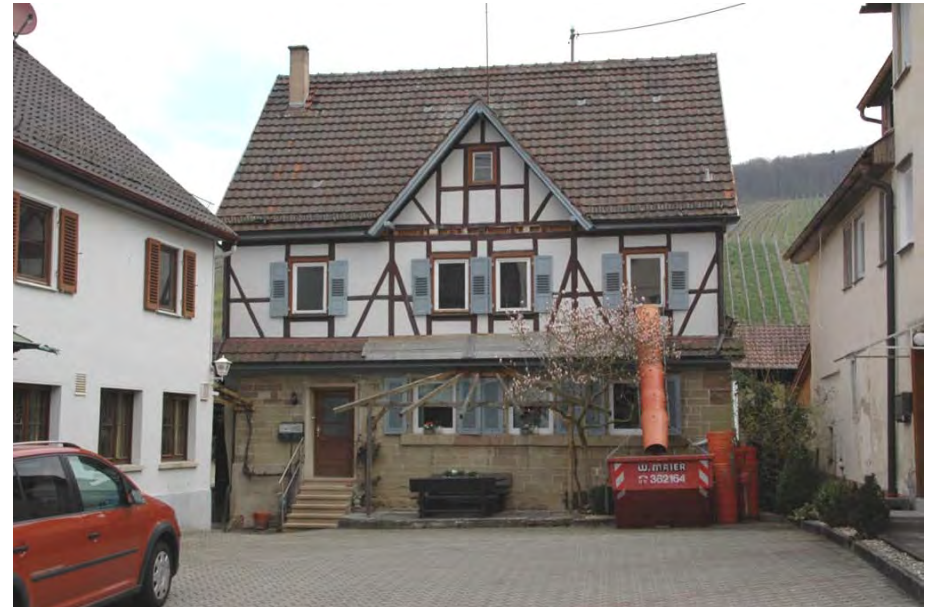
Blick auf die gegen die Hindenburgstraße ausgerichtete Hauptfassade
