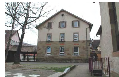
Blick auf die Nordfassade
