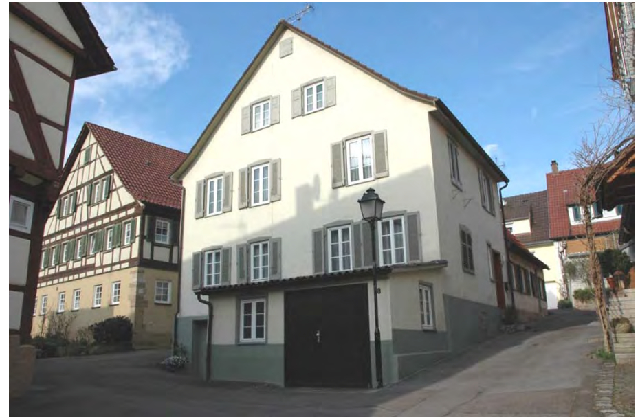
Ansicht gegen die Hauptstraße
