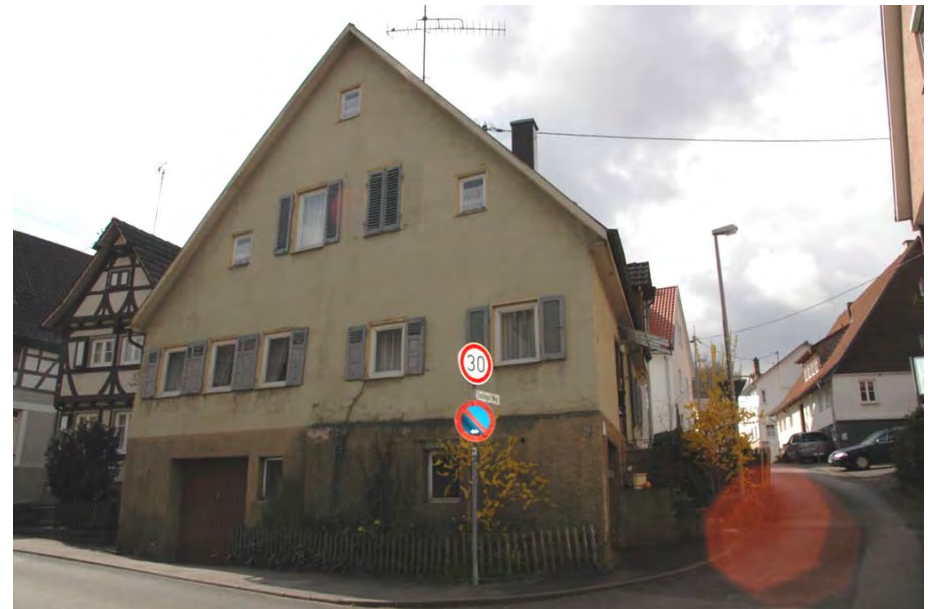
Giebelansicht gegen die Hindenburgstraße
