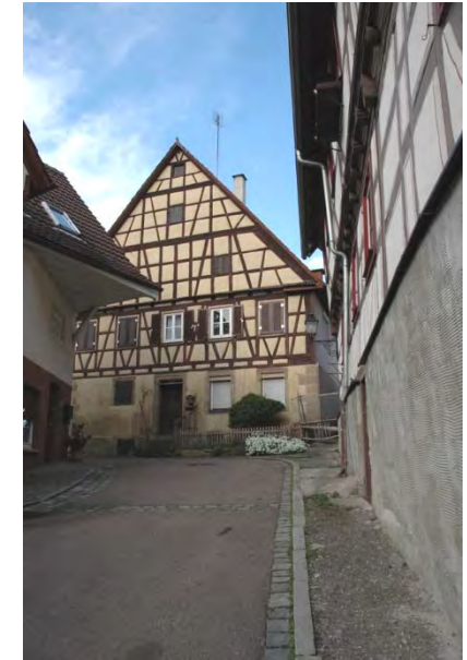
Giebelansicht gegen Südwesten
