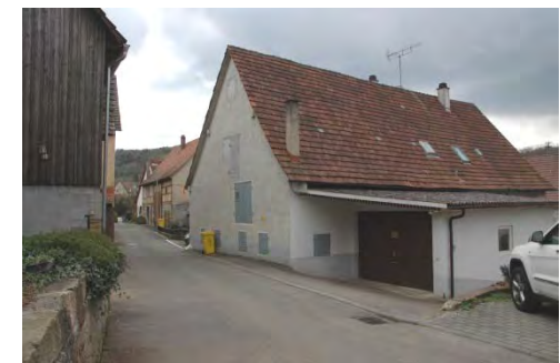
Ansicht gegen die Hintere Straße
