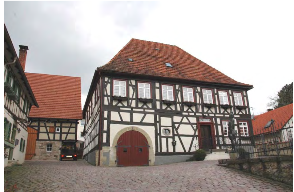
Ansicht gegen die Hauptstraße
