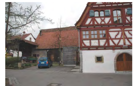
Blick auf die Stall-Scheune
