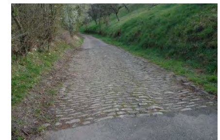
Reste der alten Straßenpflasterung
