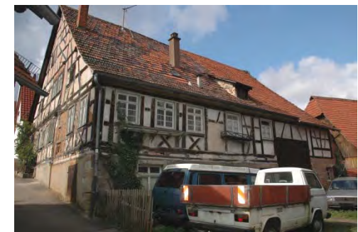
Blick auf die Ostfassade
