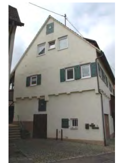
Blick auf die Ostfassade
