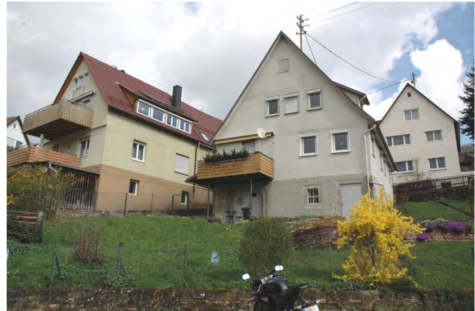
Blick auf die Südwestfassade gegen die Straße „Im Oberdorf“
