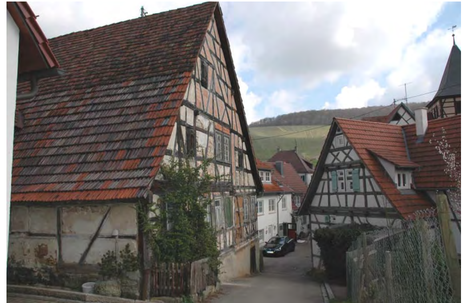
Ansicht von Nordwesten aus
