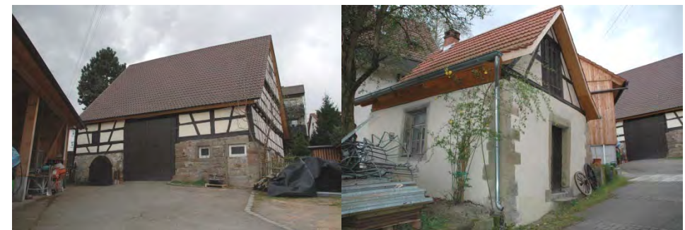
Blick auf die rückwärtige Scheune
