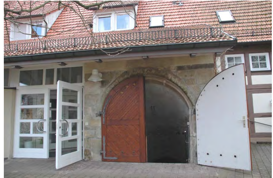
Der Kellerzugang an der stark umgebauten ehem. Scheune
