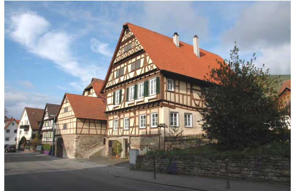
Ansicht des Wohnhauses gegen Südwesten
