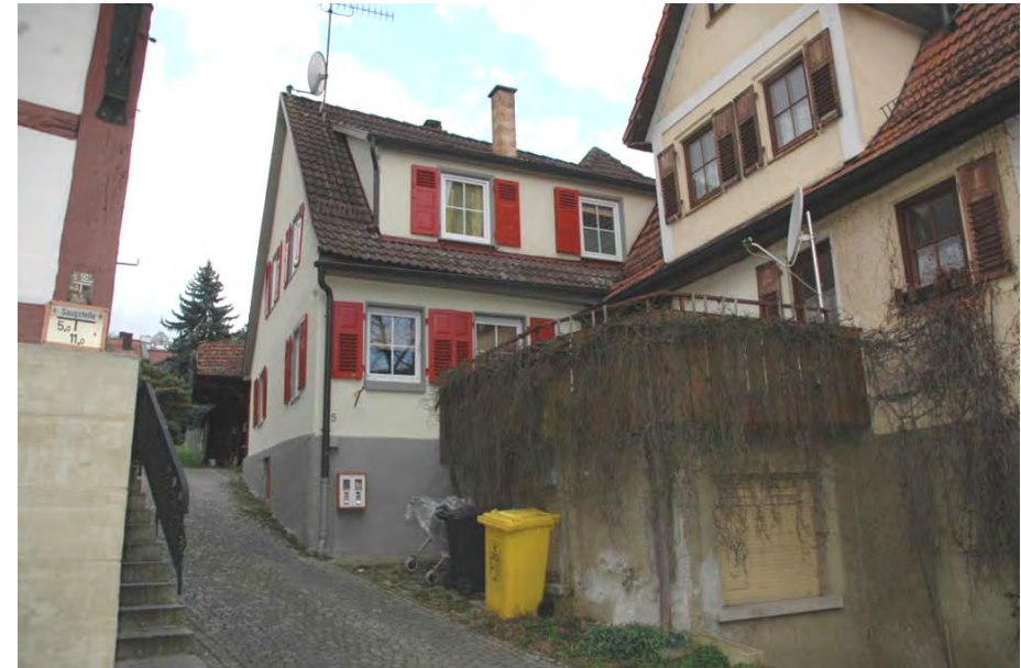
Ansicht gegen die Hauptstraße
