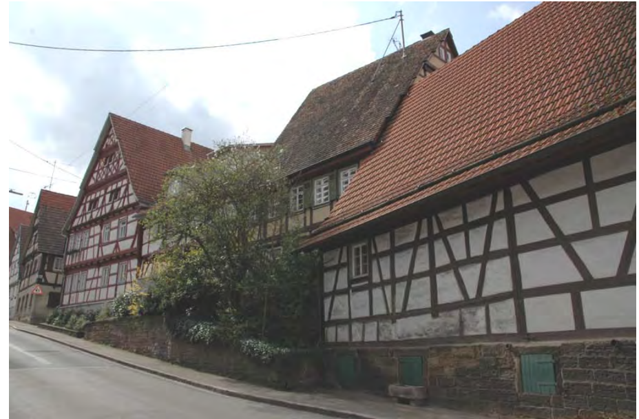
Scheune (li) und Wohnhaus (Mitte, traufständig) gegen die Hindenburgstraße
