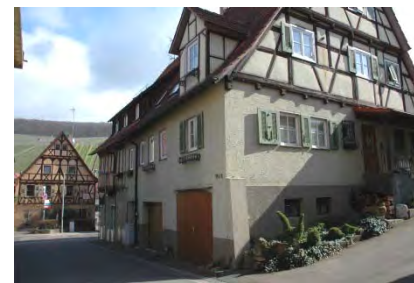
Blick auf den rückwärtigen Hausteil
