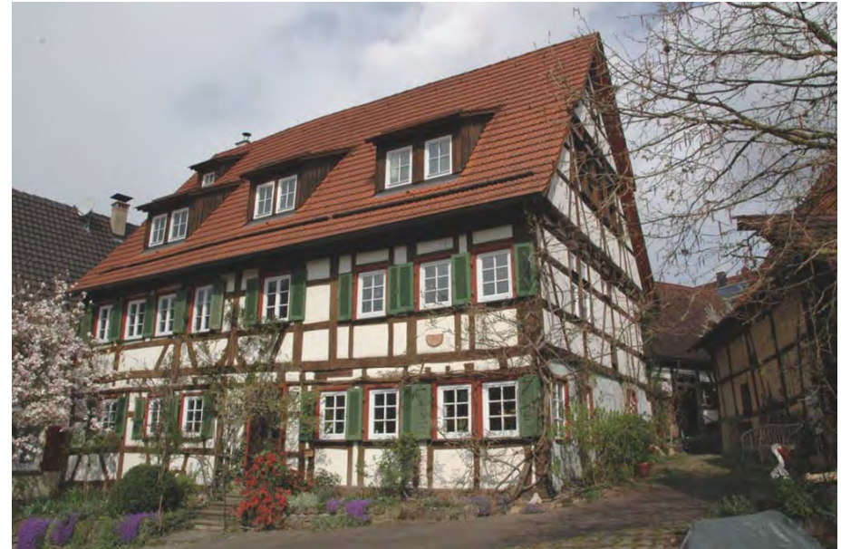
Ansicht des Wohnhauses gegen Süden, im Hintergrund das Austraghaus
