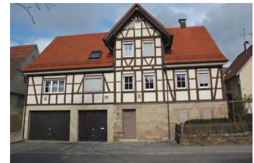
Frontalansicht gegen die Hauptstraße
