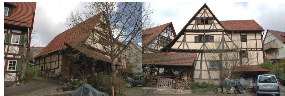
Eckansicht der Scheune
