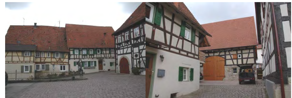
Blick auf die Nordfassaden
