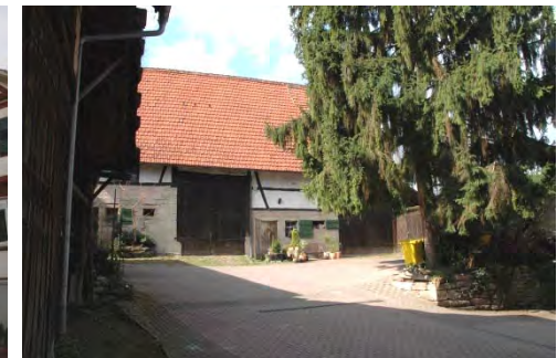
Blick auf die rückwärtige Scheune
