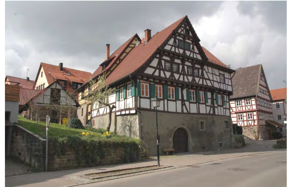
Gesamtansicht gegen Südosten, links der kleine ehem. Stall
