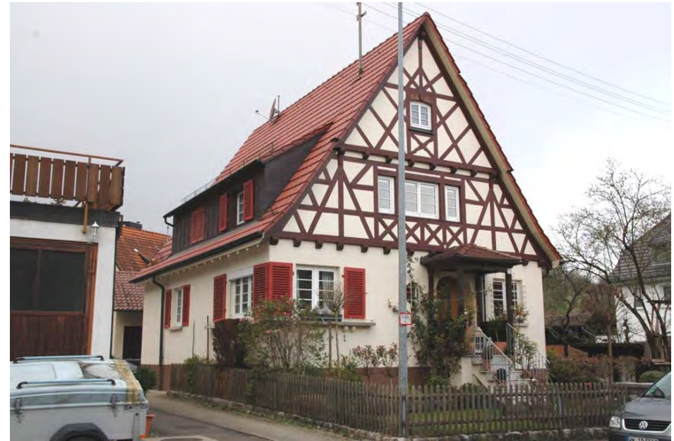
Ansicht gegen die Hauptstraße
