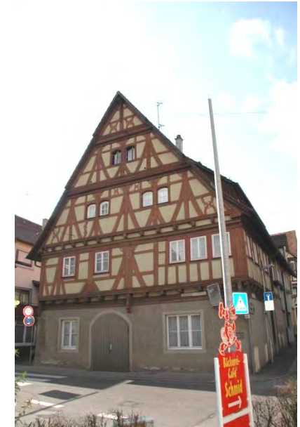
Ansicht gegen Nordosten
