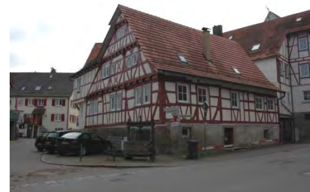
das Eckgebäude Hindenburgstr. 1
