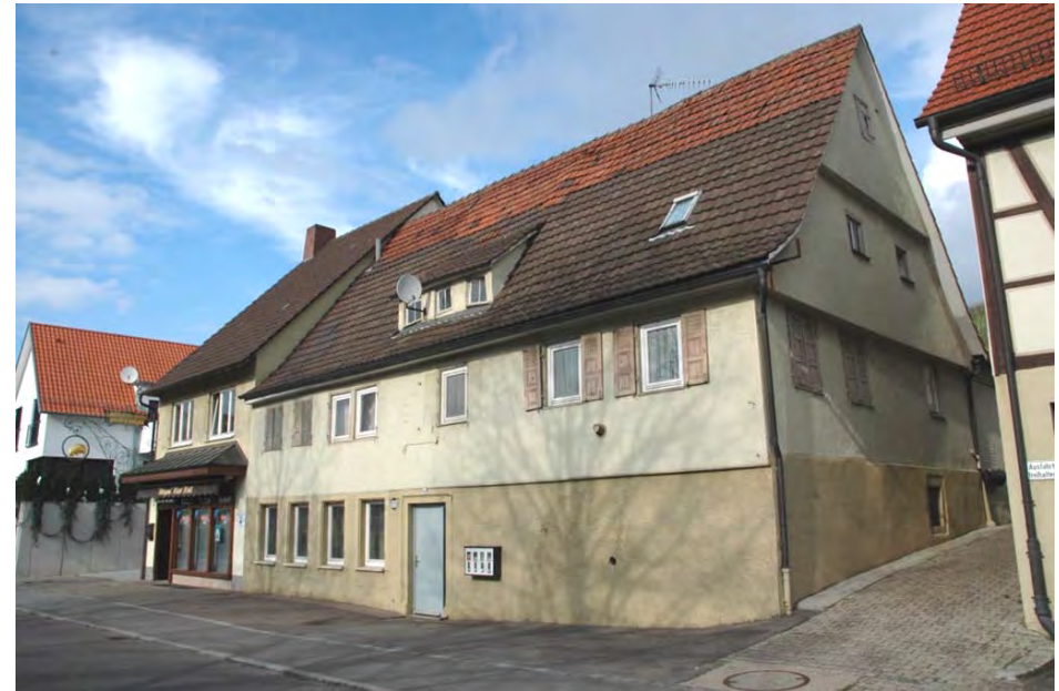
Eckansicht gegen Südwesten mit Blick auf den verputzten Fachwerkgiebel
