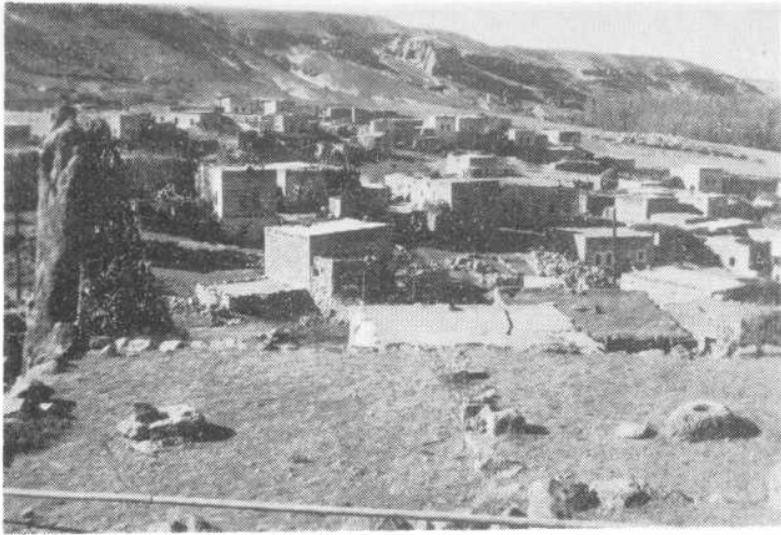
Resim: 13- Yaprakhisar köyünün yamaçtaki eski konutlarından birinin damından yeni gelişen kesime (kuzeybatı yönüne) bir bakış.
