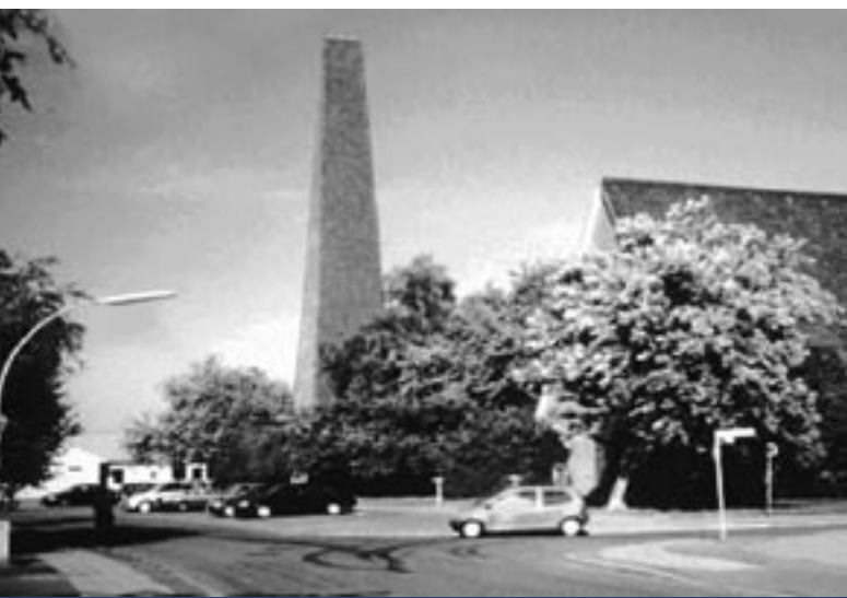
Die Versöhnungskirche an der Ecke Hermann-Tast-Straße/Berliner Straße entstand nach dem 2. Weltkrieg im neuen Stadtteil Husum Nord. Unmittelbar westlich von dem Standort der Kirche befanden sich Abstellflächen und Rollbahnen des alten Flugplatzes Schauendahl.
