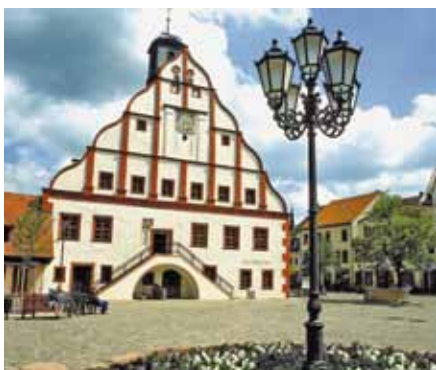
Das unverwechselbare Wahrzeichen der Stadt: das Rathaus mit der Renaissancefassade
