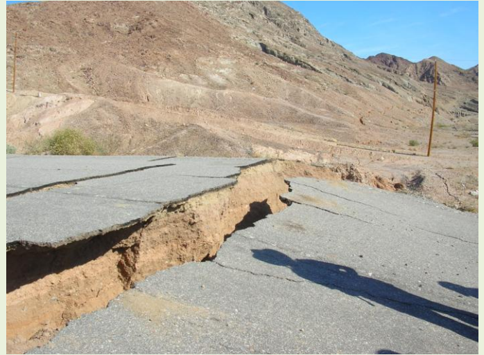
Figura 5. Tramo viejo de la carretera Tijuana-Mexicali, cortada por la falla, al este de Laguna Salada. La sombra de la persona tiene una dirección hacia el NO y se nota el desplazamiento vertical con el bloque al SE hundido con respecto al bloque al NO. Foto núm. 5762 de la autora tomada en la mañana del 27 de abril de 2010.
