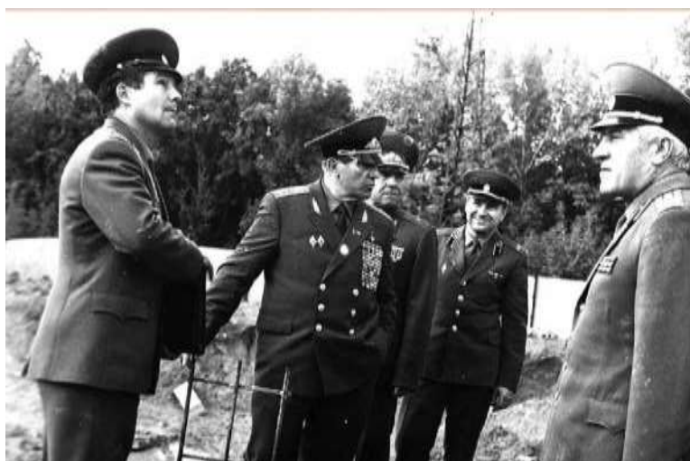
Главнокомандующий РВСН - главный маршал артиллерии Толубко В. Ф. на строительстве учебно-лабораторного корпуса
