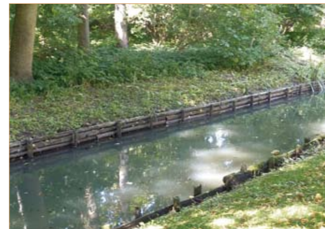
Schlosspark Molsdorf, Kanal mit pflegebedürftiger Uferbefestigung
