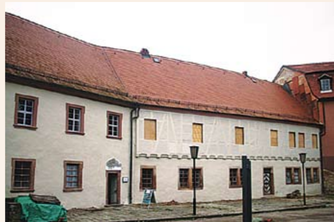
Wasserburg Kapellendorf, Hofseite des Justiz- und Rentamts nach der Sanierung
