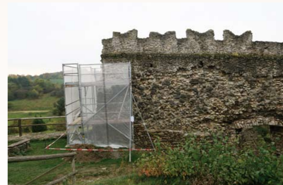
Burgruine Brandenburg in Lauchröden, Stabilisierung einsturzgefährdeter Mauerwerkbereiche
