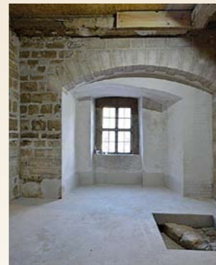
Palasturm, erstes Obergeschoss mit Resten des Eckkamins
