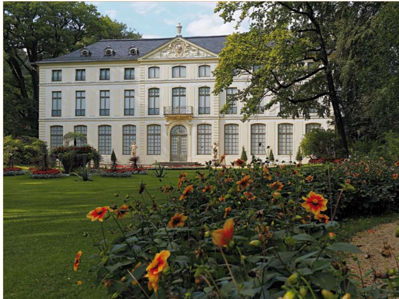
gesamt saniert: Sommerpalais im Fürstlich Greizer Park
