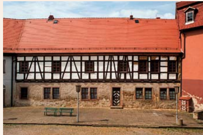
Wasserburg Kapellendorf, Hofseite des Justiz- und Rentamts vor der Sanierung
