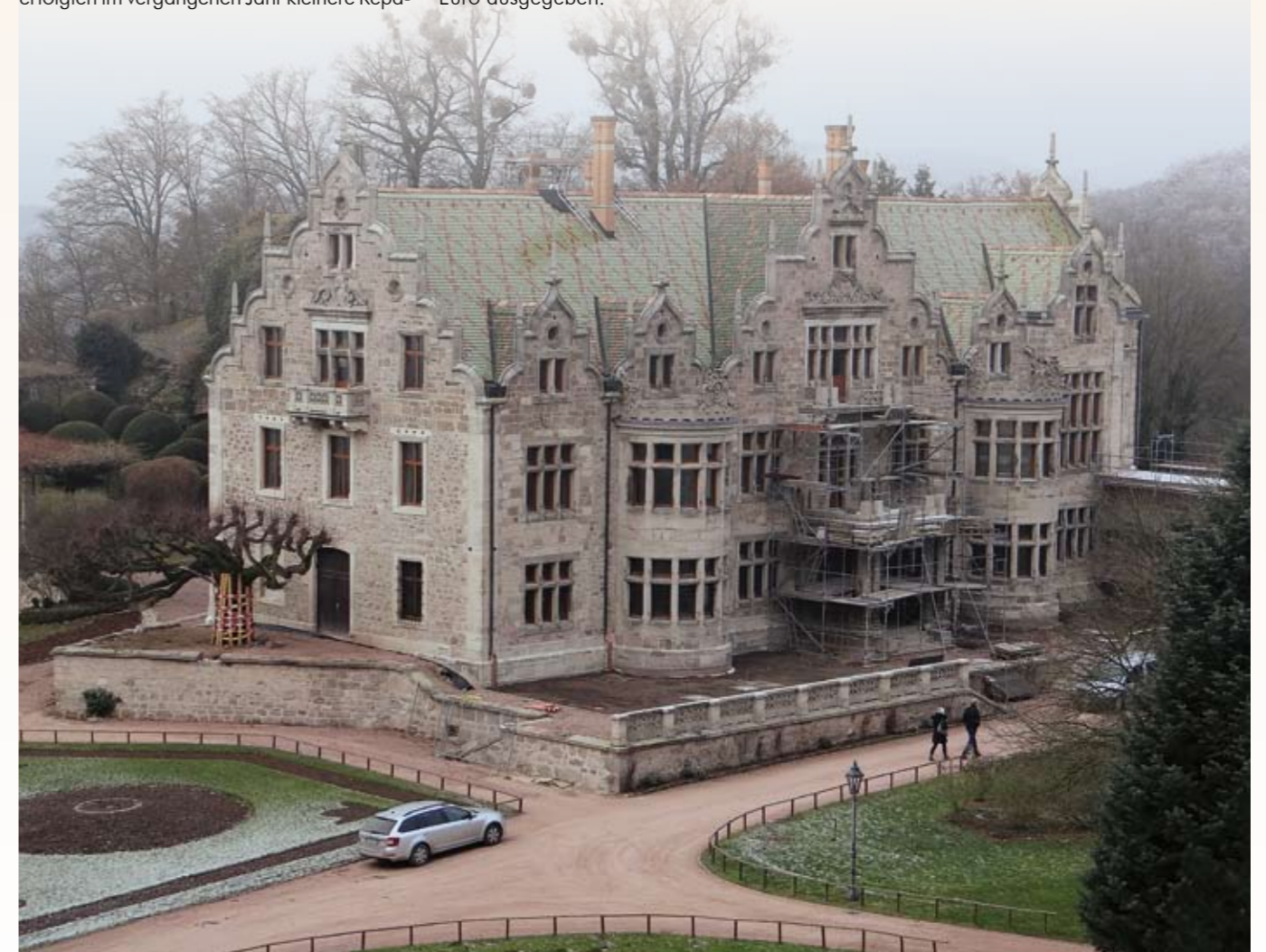
Schloss Altenstein in Bad Liebenstein, Sanierungsarbeiten an der Fassade
