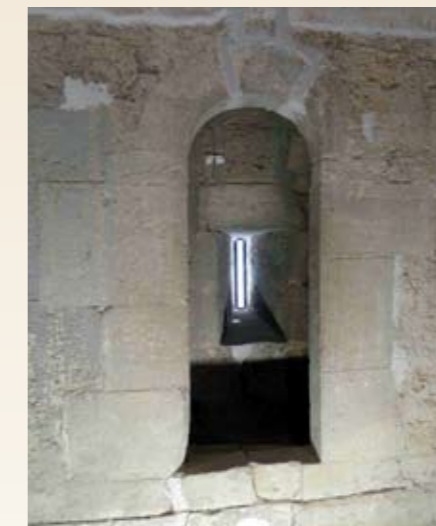
Zugang zur Wandtreppe im Palasturm
