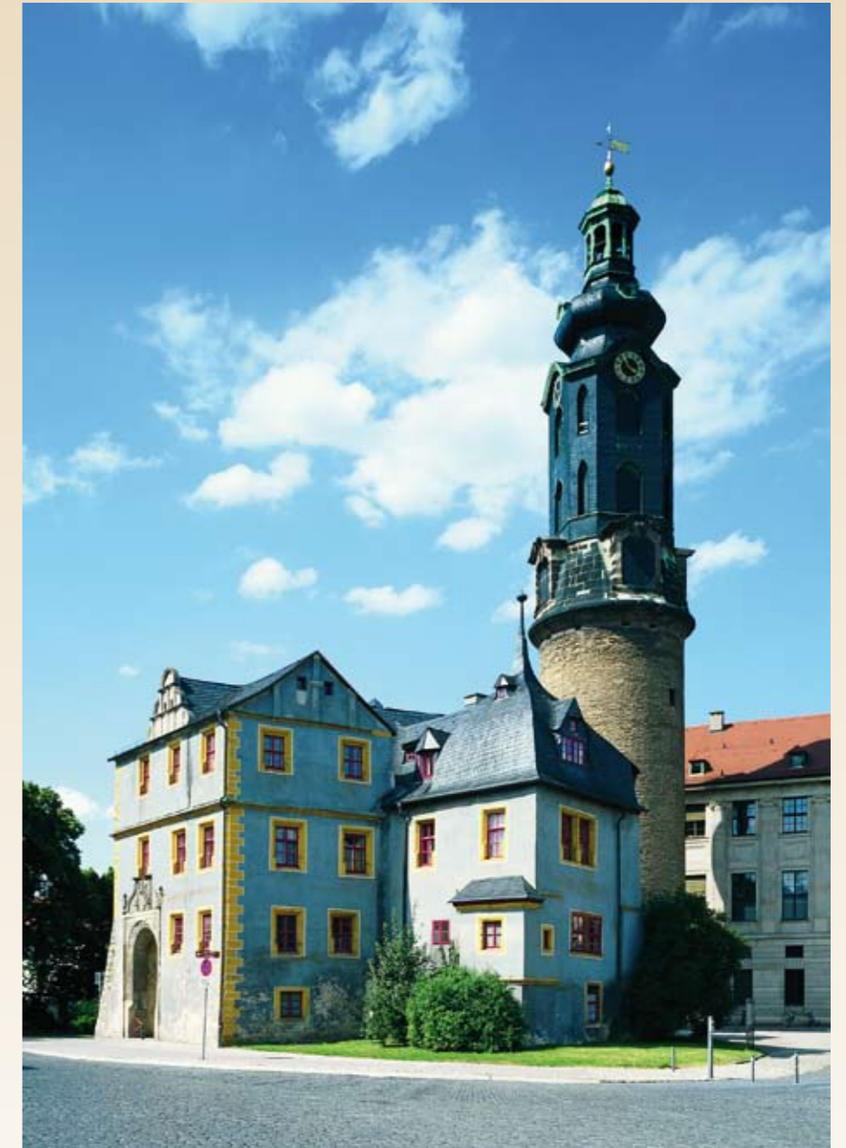
Weimar, Ensemble Bastille, Ansicht von Südosten
