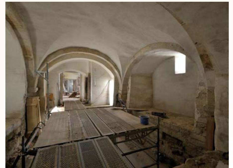
Burg Weißensee/Runneburg, Blick ins Turminnere während der Sanierung
