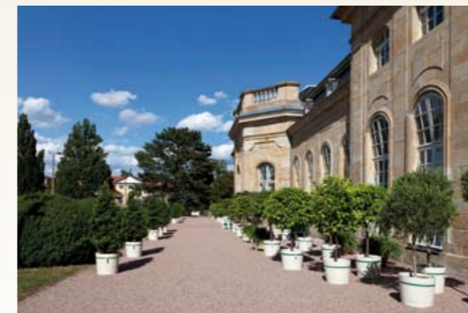
Herzoglicher Park Gotha, Orangerie, Lorbeerhaus mit Orangerieplatz
