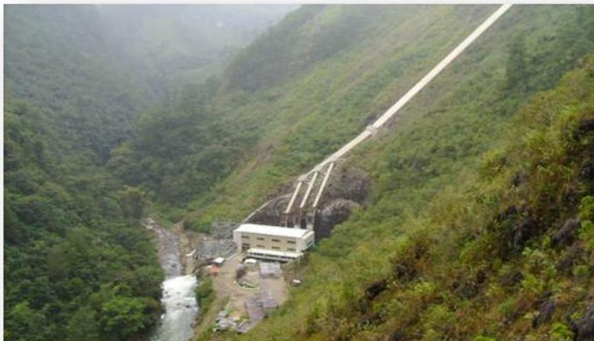
Fig. No 1.14 La Casa de Máquinas y la descarga de las aguas turbinadas al Río Cahabón.
