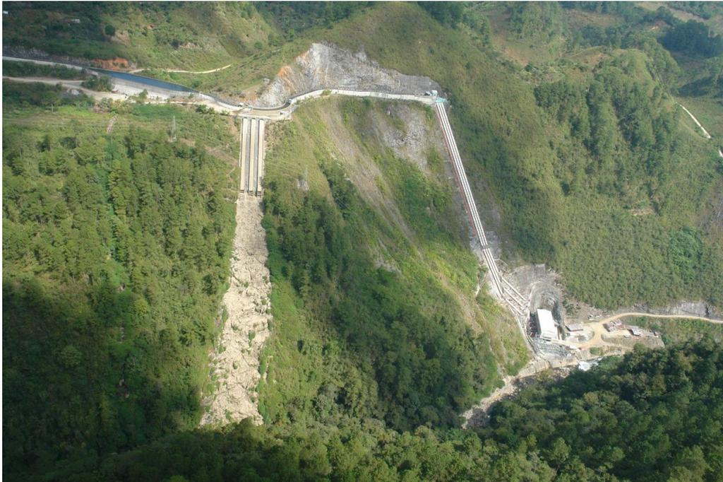
Fig. No 1.09- Fuente: RENACE S.A. Vista panorámica de la parte final de la Cámara de Carga, las tuberías de presión y la Casa de Máquinas, con su desfogue hacia el Río Cahabón; observe lo encañonado del cauce del río.
