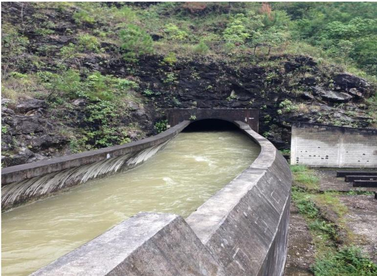
**Foto F.6** Vista, hacia aguas abajo de la transición del canal hacia el túnel.
