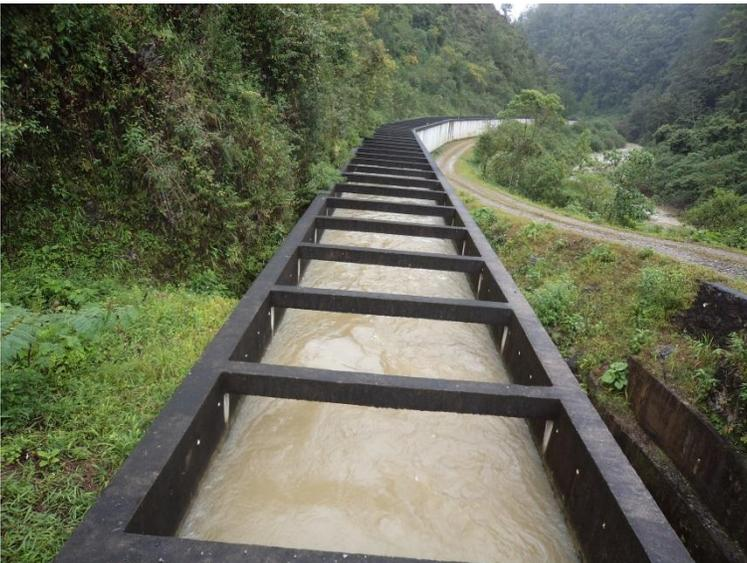
**Foto F.4 Vista del muro derecho del Canal de Conducción, camino de mantenimiento a lo largo del mismo y cauce del río Cahabón, lado derecho de la foto.**
