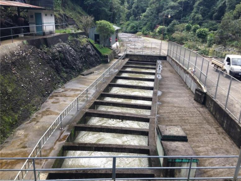
**Foto F.3 Inicio de Canal de Conducción, dejando la Toma (intake), con su sistema de rejillas y compuertas.**
