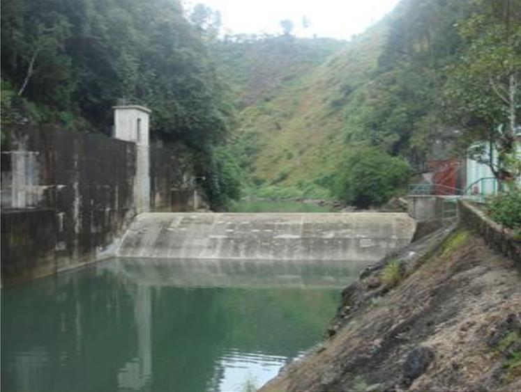
**Foto F.1 Presa tipo vertedero de derivación, vista hacia aguas abajo.**
