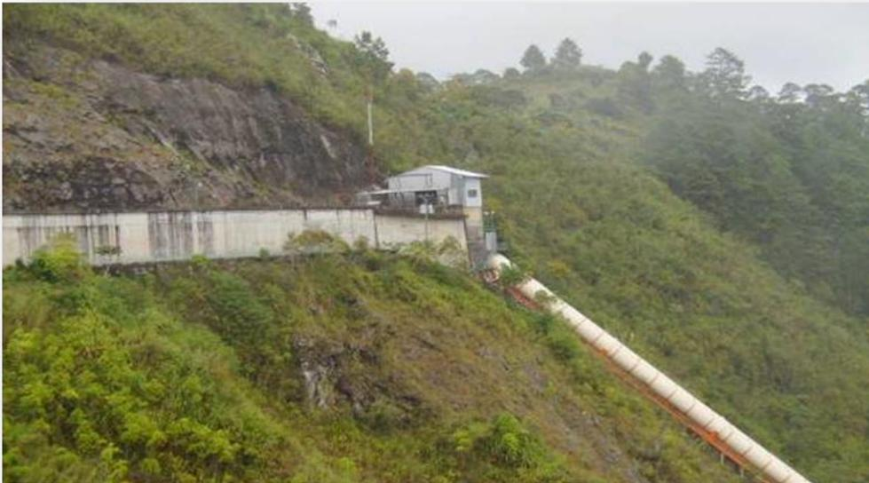
Fig. 1.12 Final de la Cámara de Carga, previo a la entrada de las tuberías de presión.
