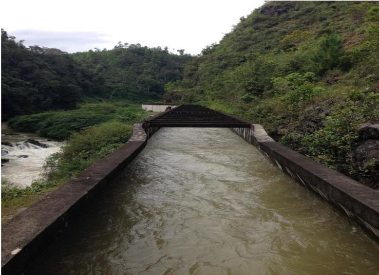
**Foto F.5** Cauce del río Cahabón, al final del tramo I de canal abierto (2,100 m aguas abajo de la presa) e inicio del túnel. Sección de cauce típica del río, en prácticamente todo su recorrido hasta aguas abajo de la Casa de Máquinas. Al lado derecho se aprecia el final del canal del tramo I
