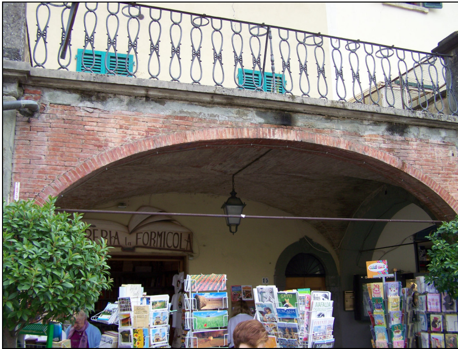
Flaches Segmentgewölbe in Greve, Toscana mit Zugglied.
