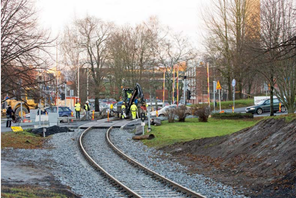
Kuva 51. Vaasan ja Vaskiluodon välinen rata peruskorjattiin Vaasan kaupungin ja Liikenneviraston yhteishankkeena loppuvuonna 2016. Viimeistelytyöt olivat käynnissä 24.11.2016 Kirkkopuiston (Wolffintie) tasoristeyksessä.
