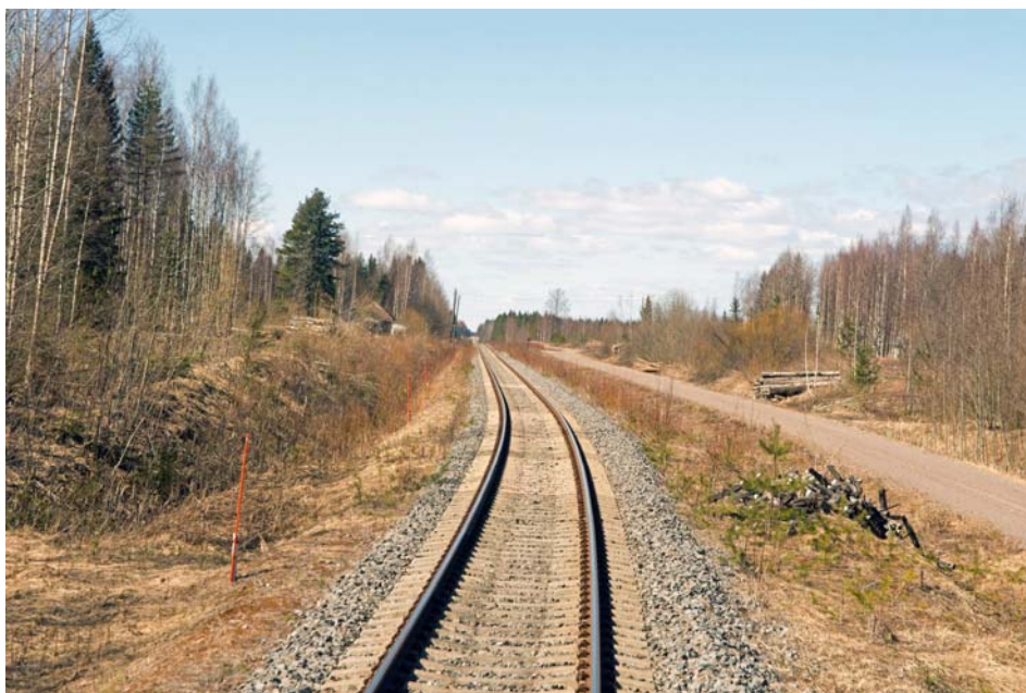
Kuva 59. Perusparannuksessa vuosina 2008–2009 rataosa Huutokosken ja Savonlinnan välillä varustettiin sepelitukikerroksella, betonipölkyillä ja 54E1-kiskoilla.
