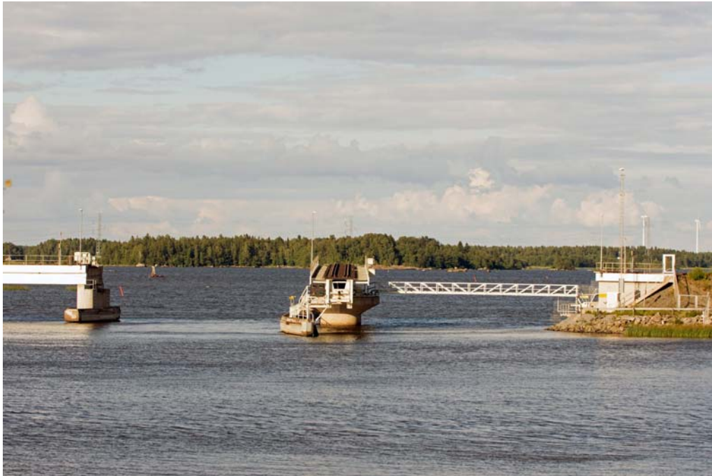
Kuva 24. Tahkoluodon avattava ratasilta pidetään vesiliikennekauden aikana avoinna vesillä liikkujille. Silta suljetaan rautatien suuntaiseksi mahdollistamaan rautatieliikenne vain junien kulkuajoina.
