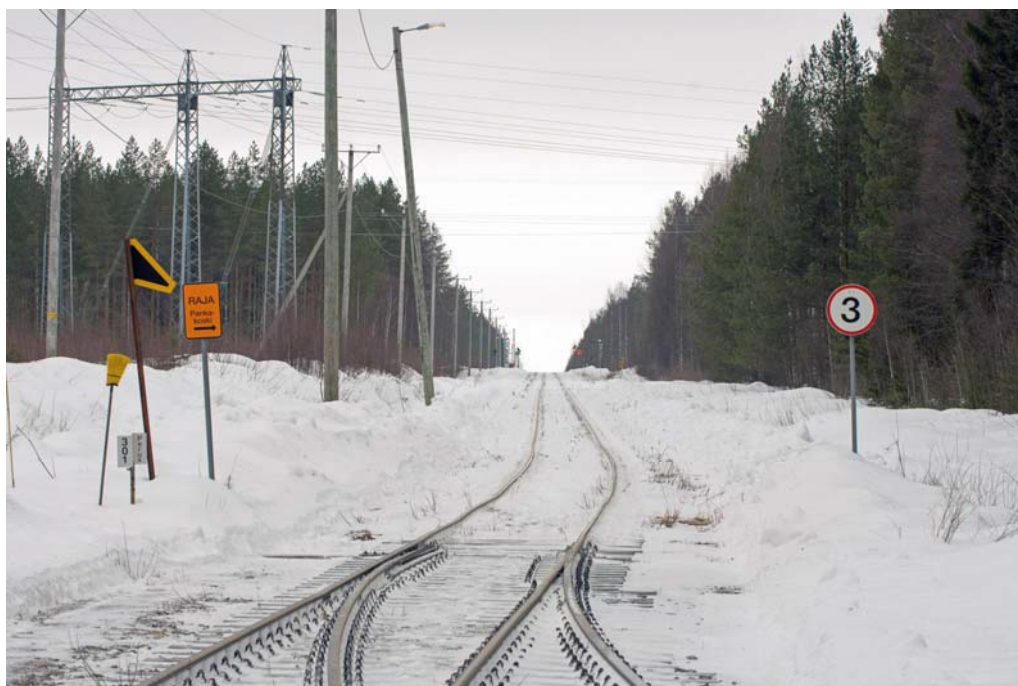
Kuva 71. Näkymä Pankakosken ratapihalta Lieksan suuntaan 8.3.2017.
