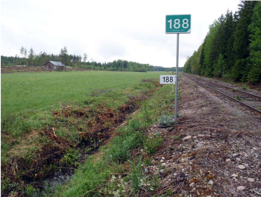
Kuva 6. Radan kuivatuksen kannalta tärkeässä asemassa on mm. sivuojen toimivuus. Ojan kasvaessa umpeen, veden virtaus heikkenee ja viimein loppuu. Vesi kuitenkin löytää aina reitin ja pahimmillaan huuhtoo ratapenkan pois tieltään. Kuva: Janne Sorsa.
