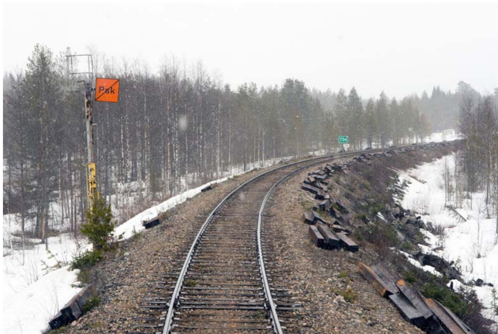
Kuva 80. Turvallisen liikennöitävyyden varmistamiseksi vaihdettiin toukokuussa 2017 lauttavaihtona kaikki ratapölkkyt Pesiökylän Ämmänsaaren suunnan lähtökaarteesta.
