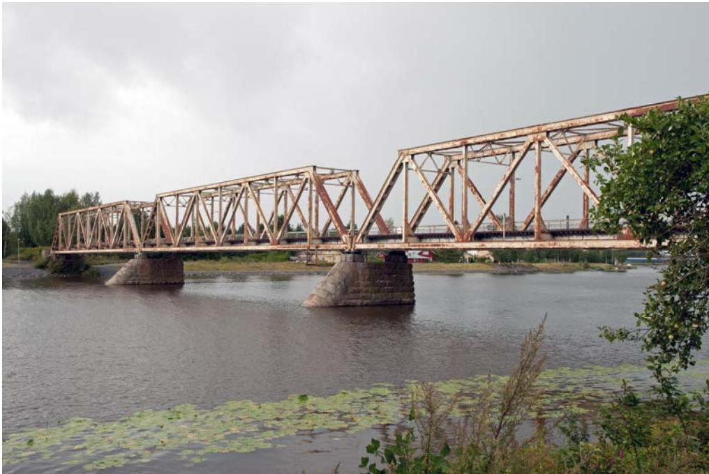
Kuva 96. Kokemäenjoen vuonna 1930 rakennettu ratasilta osuudella Aittaluoto–Ruosniemi.
