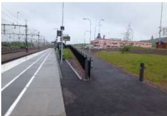
Ramp mellan busshållplatsen och tågplattformen.
