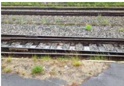
Borttagen asfalt på plattformen.
