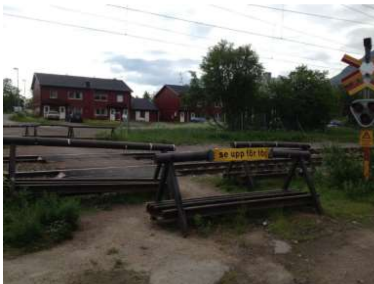
Förbindelse mellan plattform 1 och plattform 2.
