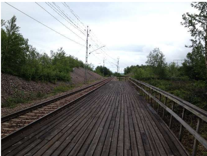
Östra delen av stationen består av träplattform.
