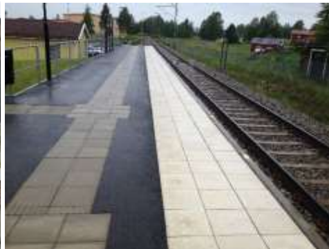
Utsikt från stationens mitt mot Väster.
