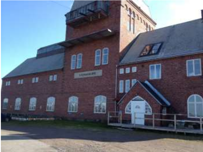
Stationshuset sett från oasfalterade parkeringen.
