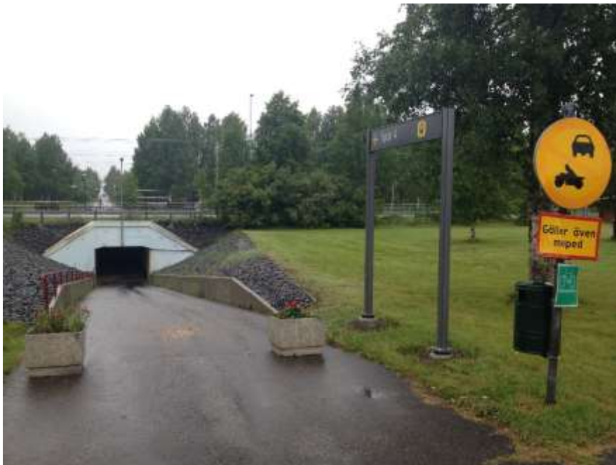
Skyltad gångtunneln som leder till plattform2 och spår 4.
