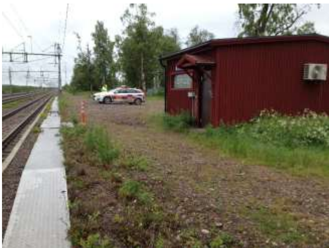
Plattformen i Krokvik är inte asfalterad.
