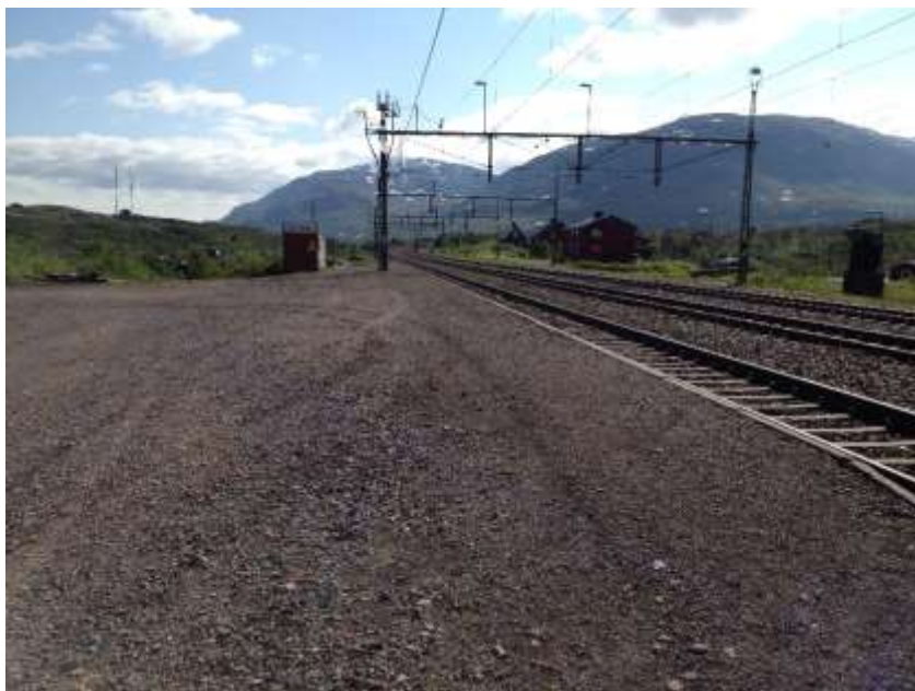
Vassijaures oasfalterade sidoplattform.
