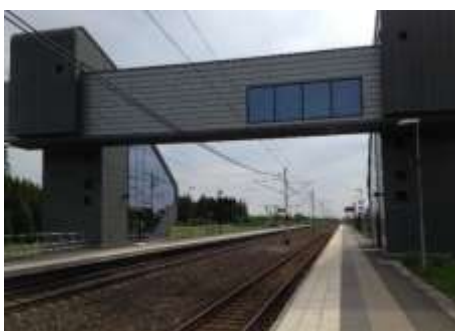
Passagen över spåren.
