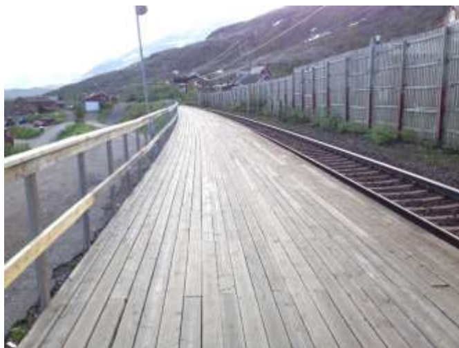
Östra delen av plattformen består av trä
