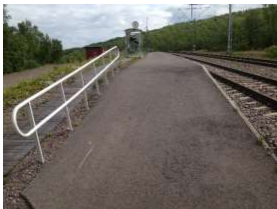
Plattformens ramp med ledstång.
