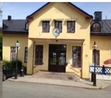
Entrén till stationshuset saknar ramp och automatisk dörröppnare.
