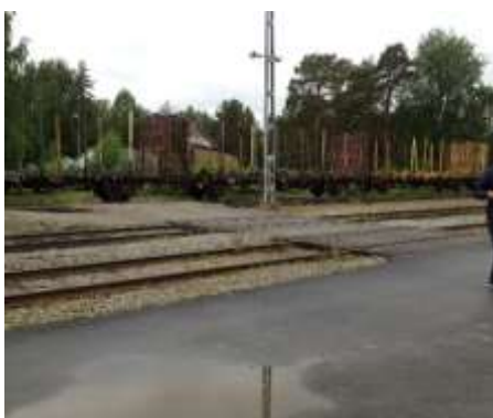
Förbindelse mellan plattformarna består av en oskyddad förbindelse över spår i plan.
