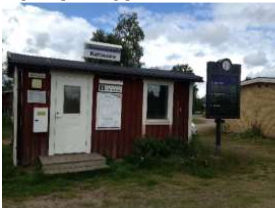
Väntsalen i Nattavaara station.
