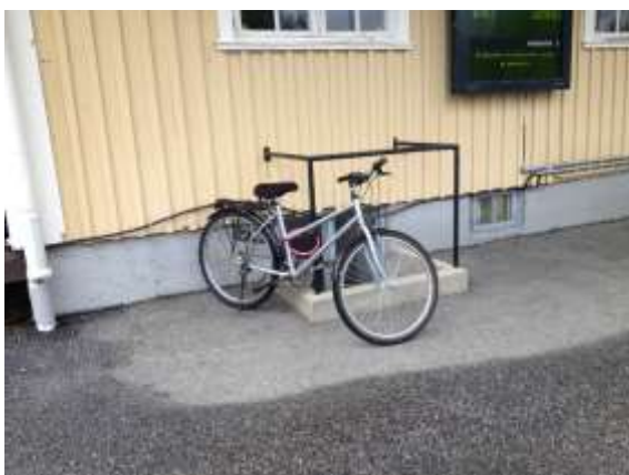
En cykel som står parkerad och stör en potentiell utrymningsväg.
