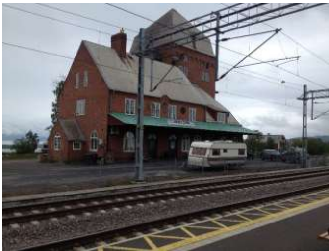
Gamla stationshuset sett från plattformen.
