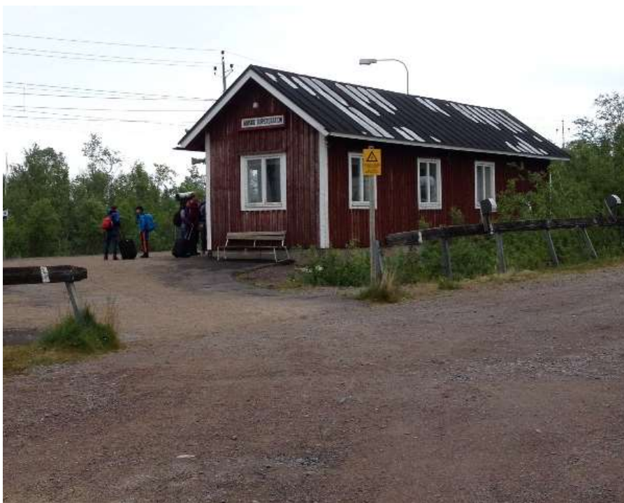
Förbindelse till plattformens mitt.
