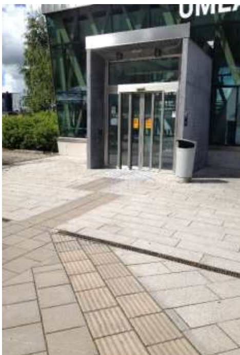
Bild 3.6 Olika taktila gångstråk ansluter inte till varandra, Umeå östra.
