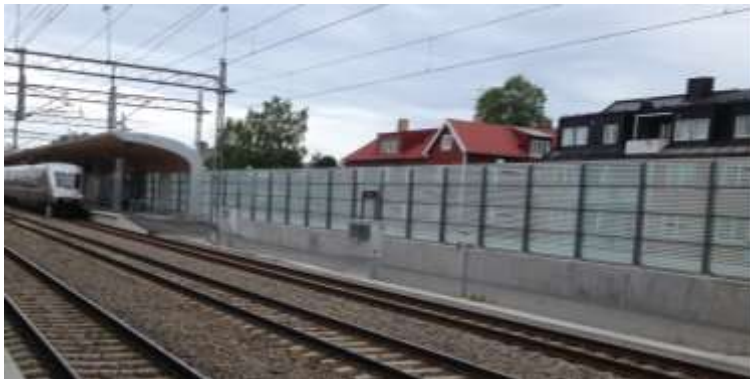
Bild 9.1 Bullerplank av glas, Umeå C.
