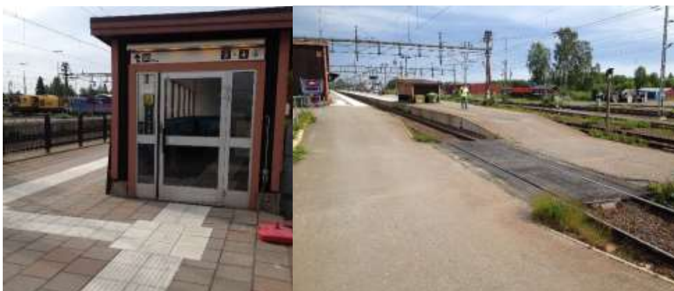
Trapphus med hiss på Boden station. Förbindelse över spår i plan mellan spår 3 och 4.
