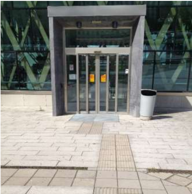
Utanför stationens östra ingång möter inte de olika ledstråken varandra.
