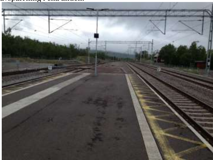
Plattformens västra ände saknar avspärning.
