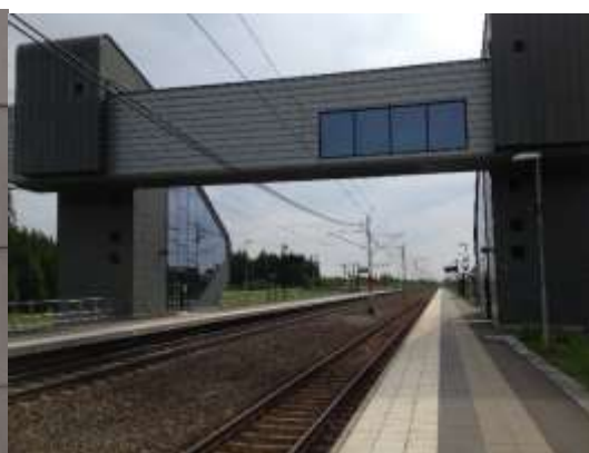
Passagen över spåren.
