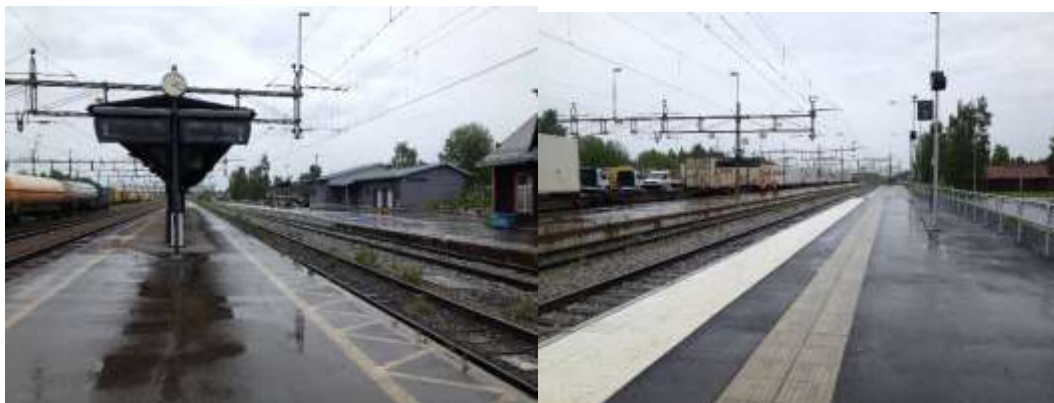
Mellanplattformen med plattformstak.
