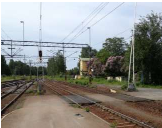
Bild 4.1 Förbindelse i plan över spår. Skyddat av bommar och signal, Boden C.
