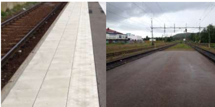
Bild 2.3 Målade plattor utgör skydds-zonen, Boden.
