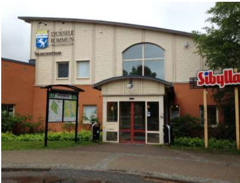
Huvudentrén till resecentrets byggnad.
