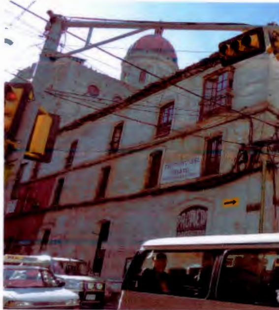
Fachada frontal – lado sur (calle Potosí)
